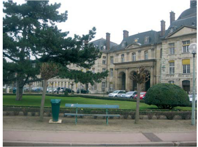
Figura 3 Edificio asistencial moderno.
