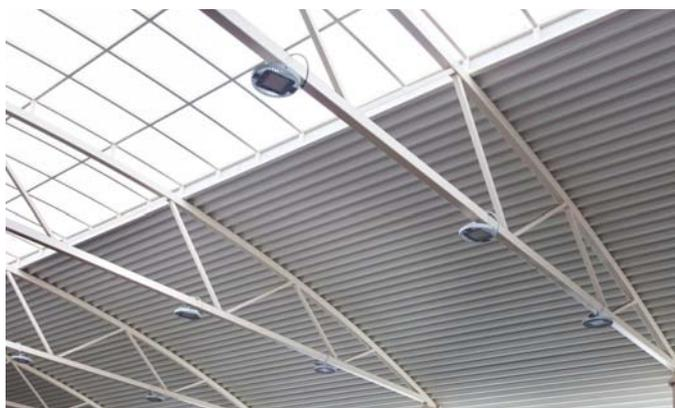
Vista interior de la nave, con celosías metálicas con perfiles tubulares y chapa grecada
