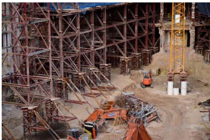
**Figura 2.** Vista inferior de las torres de estabilización en la fachada de Alcalá 14
