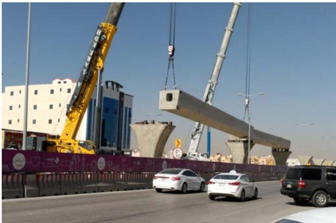
Colocación de vigas tipo de 36 m
