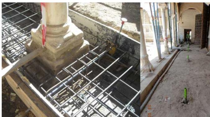
Refuerzo de cimentación con barras Freyssibar e inyecciones armadas para consolidación del terreno
