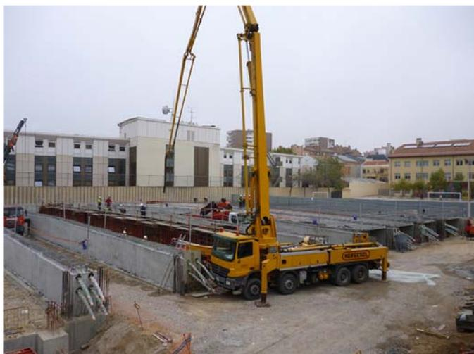
Figura 1. Ejecución vigas cubierta polideportivo
