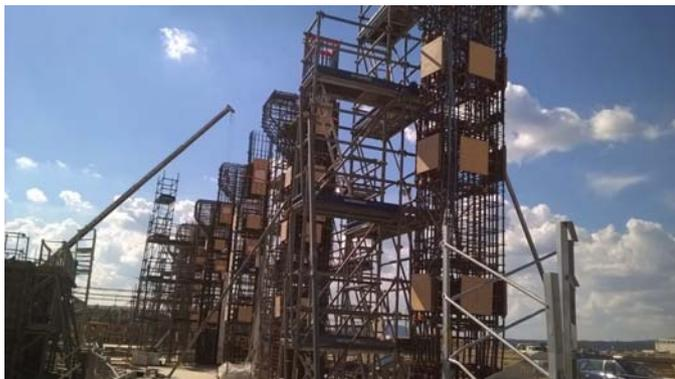
*Pilares ferrallados y montados, preparados para su encofrado y hormigonado*
