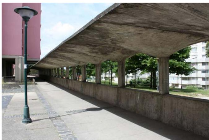
Paso cubierto con paraboloides disimétricos
