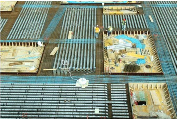
Techo montado/ferrallado previo al hormigonado
