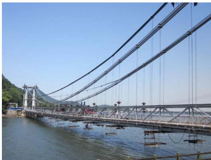
Cables definitivos colocados y tesados. Cables provisionales destesados
