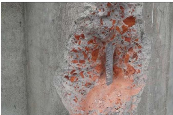
Cata estructural mostrando el hormigón con árido a base de trozos de ladrillo
