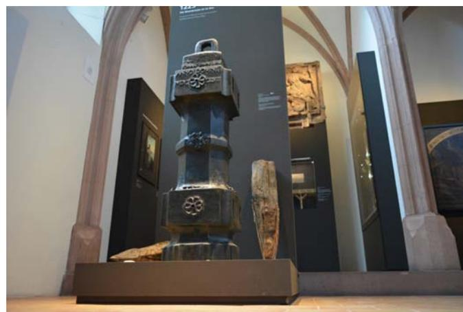
**Figura 2.** Martinete y puntaza de un pilote de puente en Basilea
