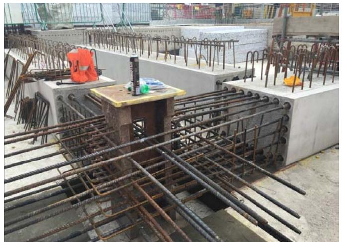
Detalle de conexión de prefabricado con nudo in situ
