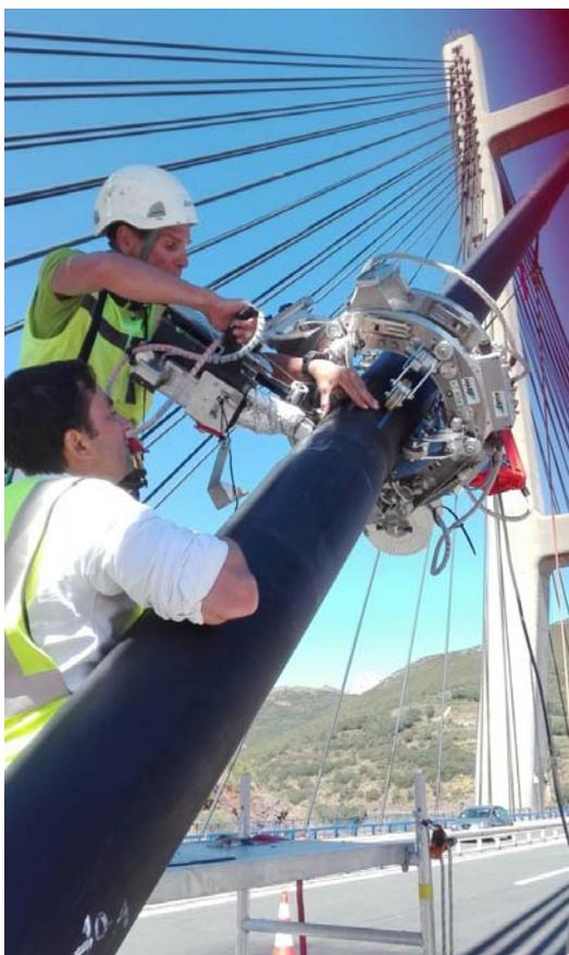
Robot para soldadura radial de vaina
