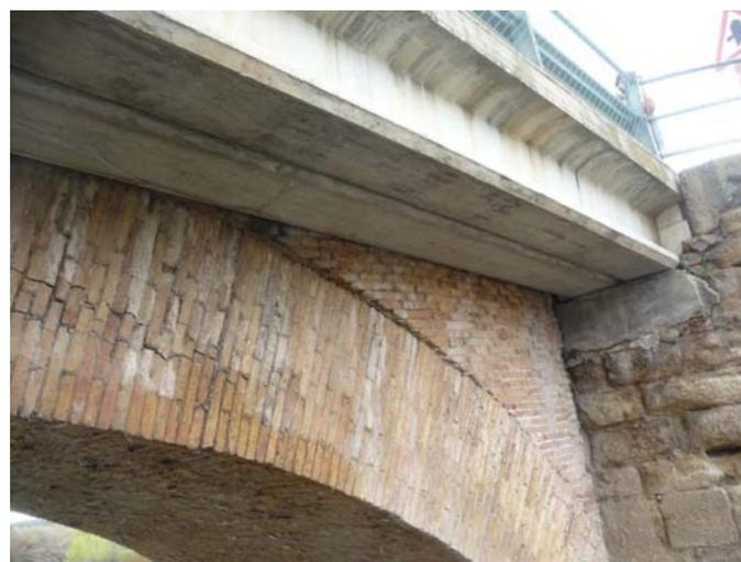
**Figura 1.** Pareja de vigas dispuestas para ensanchar la plataforma de un puente de ladrillo
