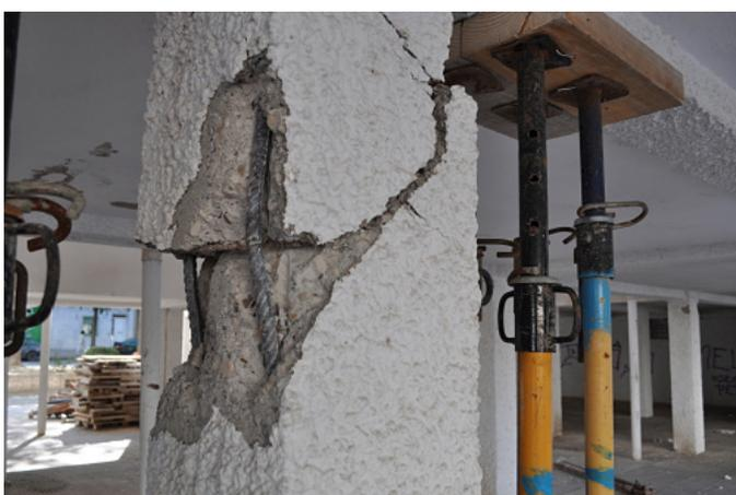
Daño a cortante de una columna
