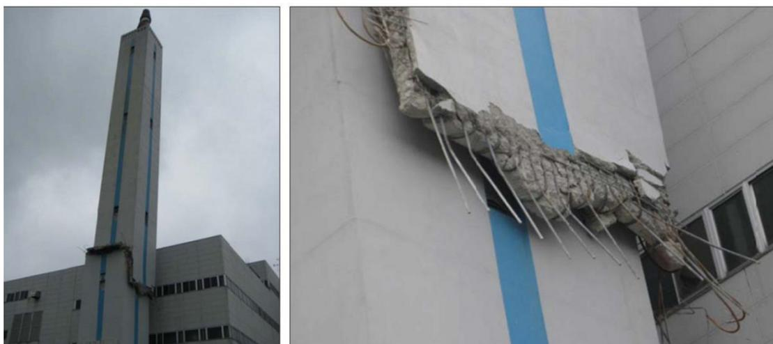
Fallo de una chimenea en Japón, debido a una insuficiente longitud de solapo
