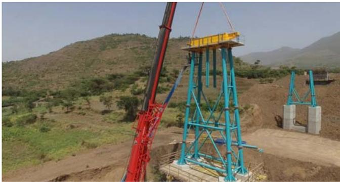
*Pila metálica en celosía de acero*
