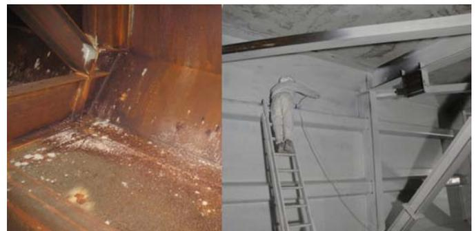
Antes y durante la aplicación de una capa de pintura en interior del cajón metálico
