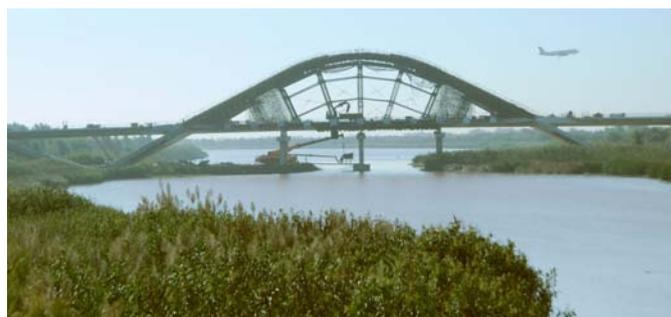
Cimbra del arco y pilas provisionales en el puente Nelson Mandela sobre el Río Llobregat (2014)
