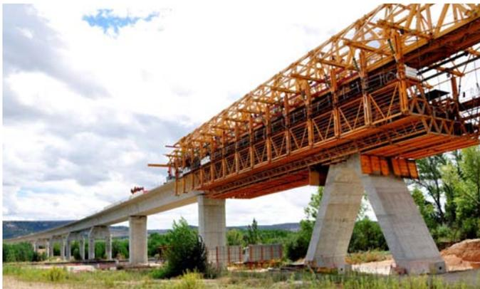
Lanzamiento de viaducto con autocimbra superior. Paso por pila en A (punto fijo del tablero)
