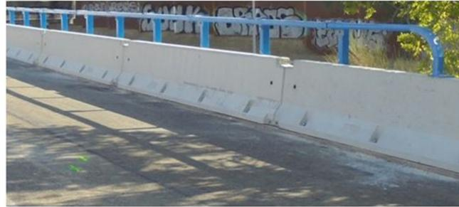
Sustitución de pretel H4b de hormigón anclado químicamente
