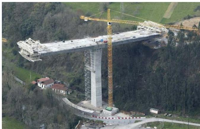
Detalle de construcción mediante carros de avance de voladizos sucesivos en Pila 6
