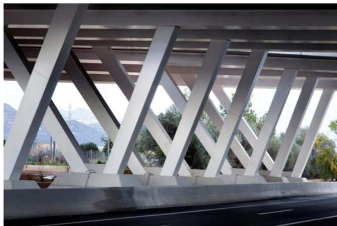
Vista de las pilas metálicas en V y su unión con los cajones metálicos del tablero
