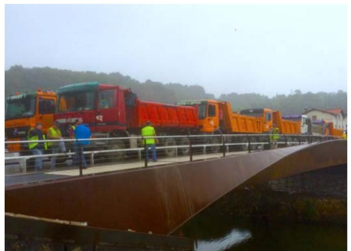
Puente Bicontentio en Martutene. Prueba de carga
