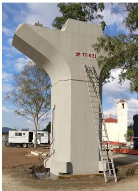
Montaje en blanco de subestructura prefabricada
