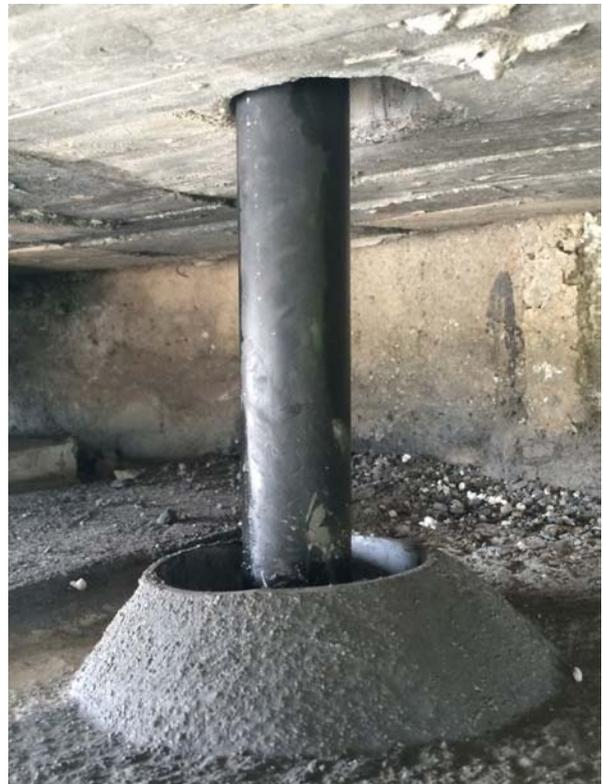
Anclaje vertical con barras pretensadas autoprotegidas
