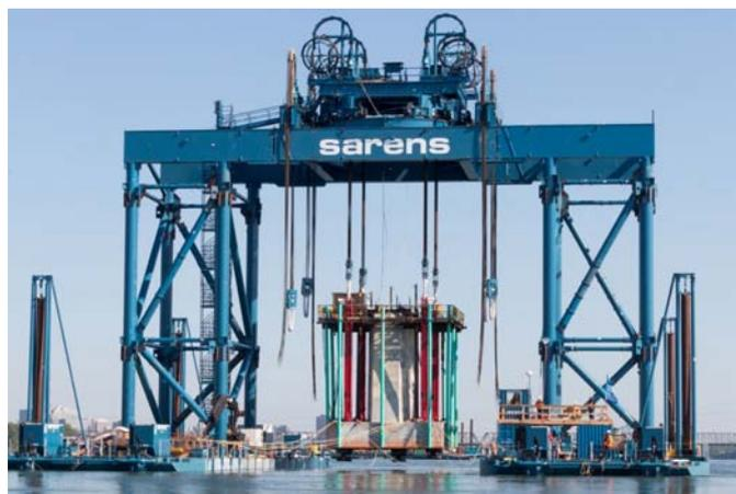
FFI (Floating Foundations Installer) navegando con una zapata colgada para instalarla en su posición
