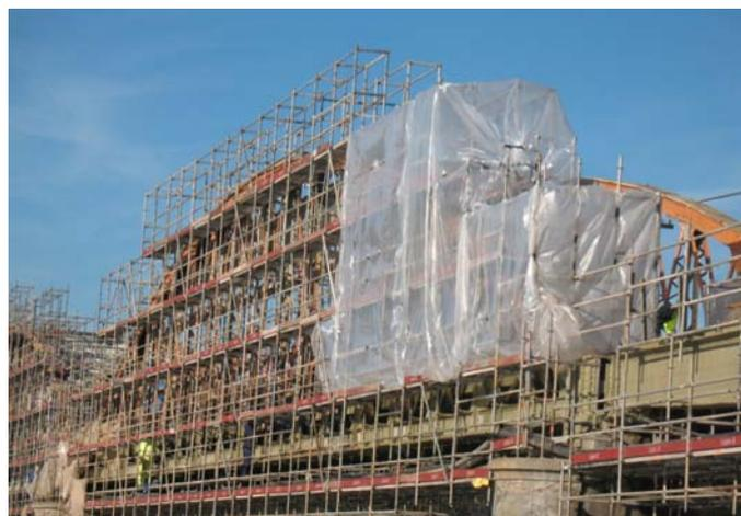
*Encapsulado y medios auxiliares durante la construcción*
