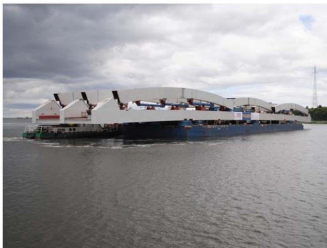
*Transporte fluvial del arco pre-montado*
