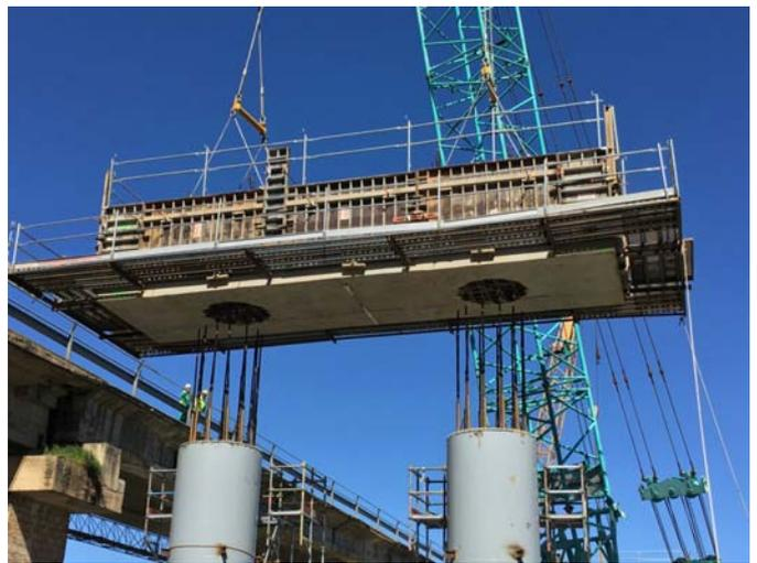
*Descenso de prelosa de dintel y pretensado de cabeza de pilas en espera*
