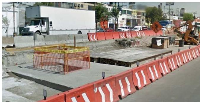
Cimentación tipo cáliz para las pilas prefabricadas
