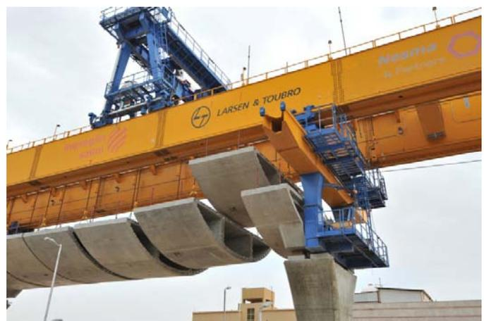
*Izado de segmentos en vanos isostáticos. Estado previo al ensamblaje y tesado del vano*
