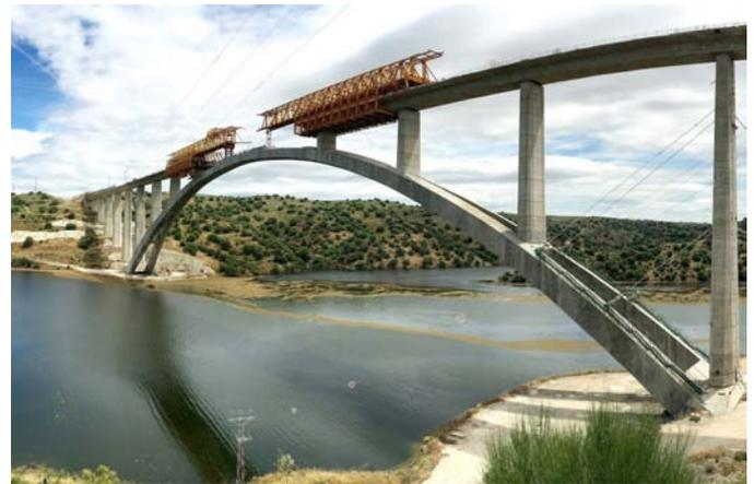
Construcción del tablero mediante autocimbra
