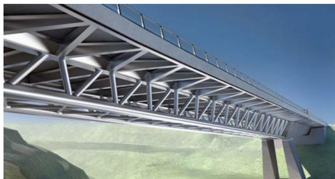
Figura 2. Fotomontaje del detalle de la celosía del puente
