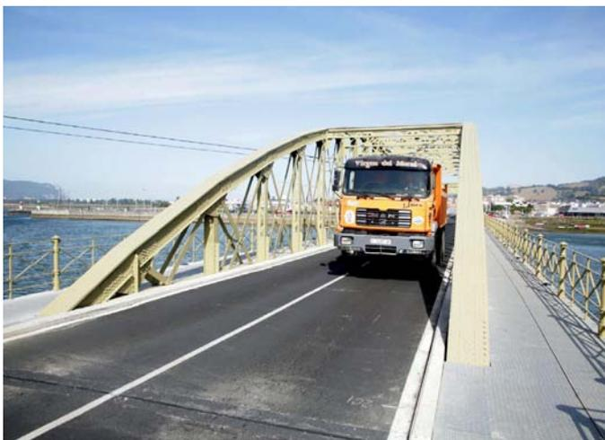
Prueba de carga dinámica excéntrica
