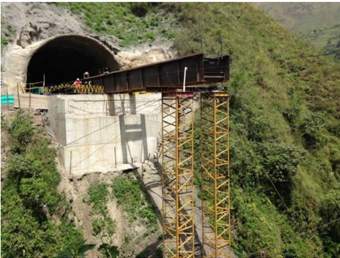
Lanzamiento de estructura metálica desde el vecino túnel
