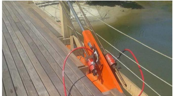
*Tesado de barras mediante barras auxiliares*
