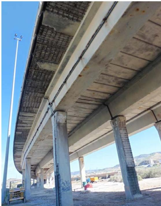
*Reparaciones en pilas y losas*
