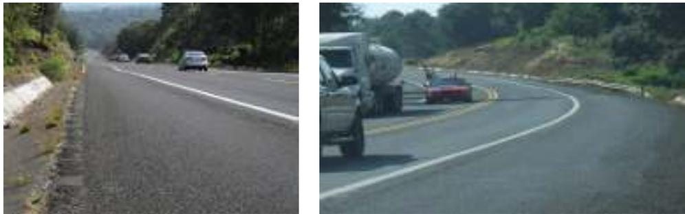
Figura 1. Problemática típica de asentamientos en la zona de la autopista
