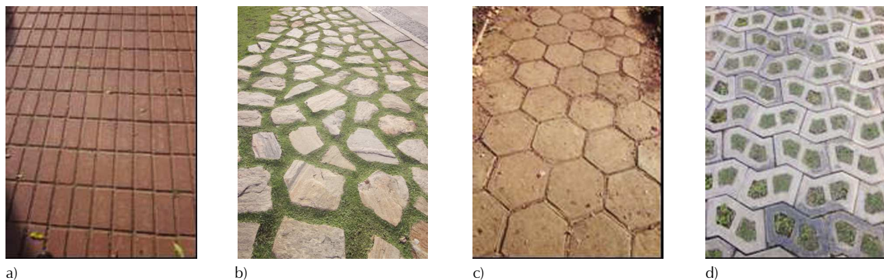
Figura 1a. Pavimentos con: a) bloque rectangular de concreto, b) bloque irregular de piedra, c) bloque hexagonal de concreto y d) bloque de concreto con hueco
