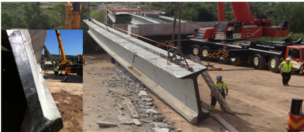
Figura 3. Configuración de izado y deformada.
