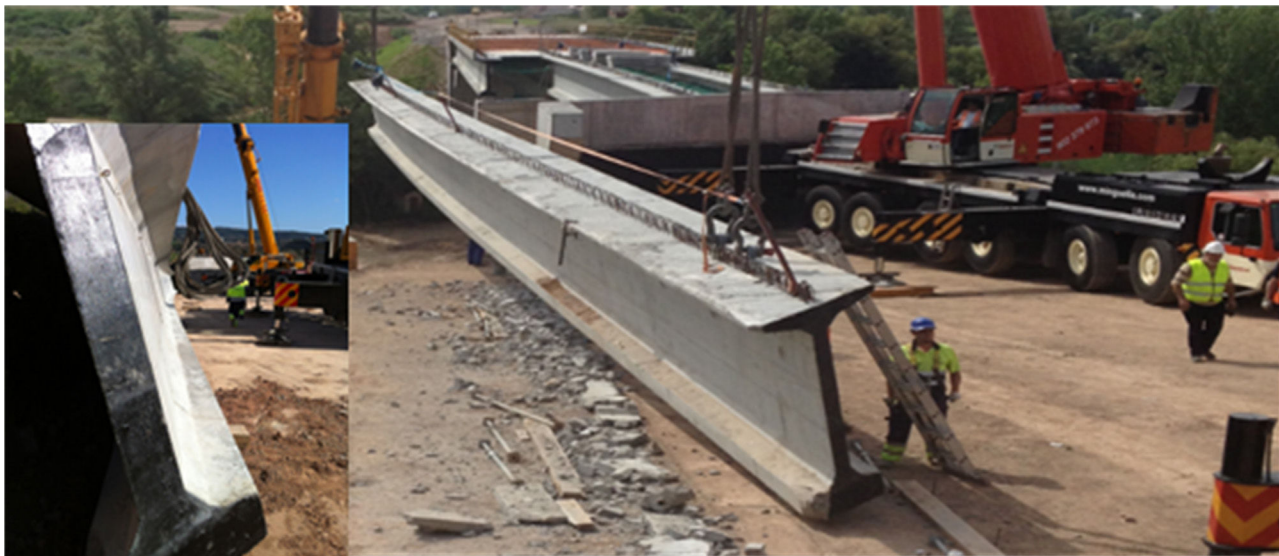
Figura 3. Configuración de izado y deformada.
