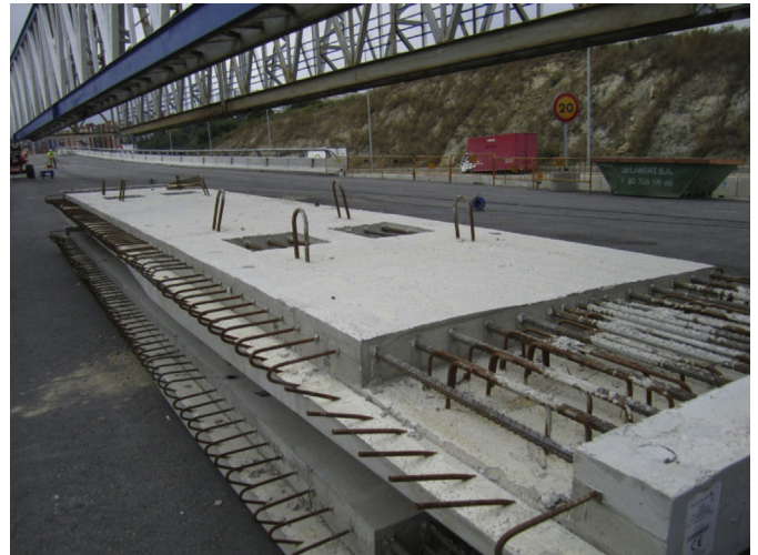
Figura 12. Losas prefabricadas de tablero.
