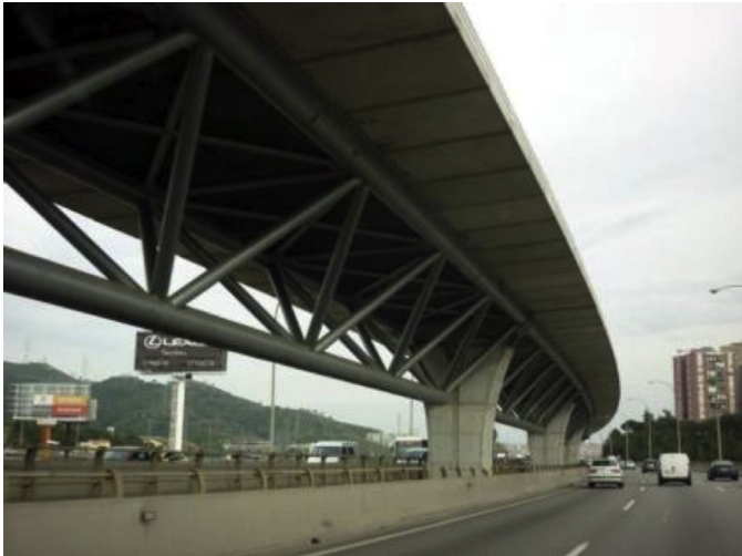
Figura 1. Vista del tablero.
