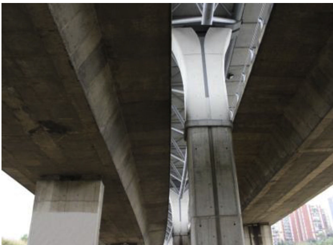
Figura 2. Pila del viaducto Bus-Vao.
