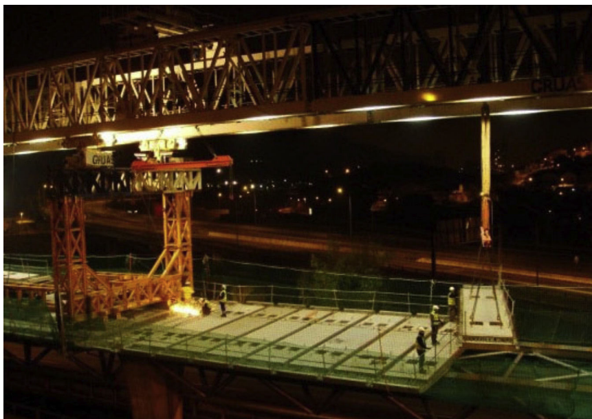
Figura 26. Montaje de losas prefabricadas con el lanzador.
