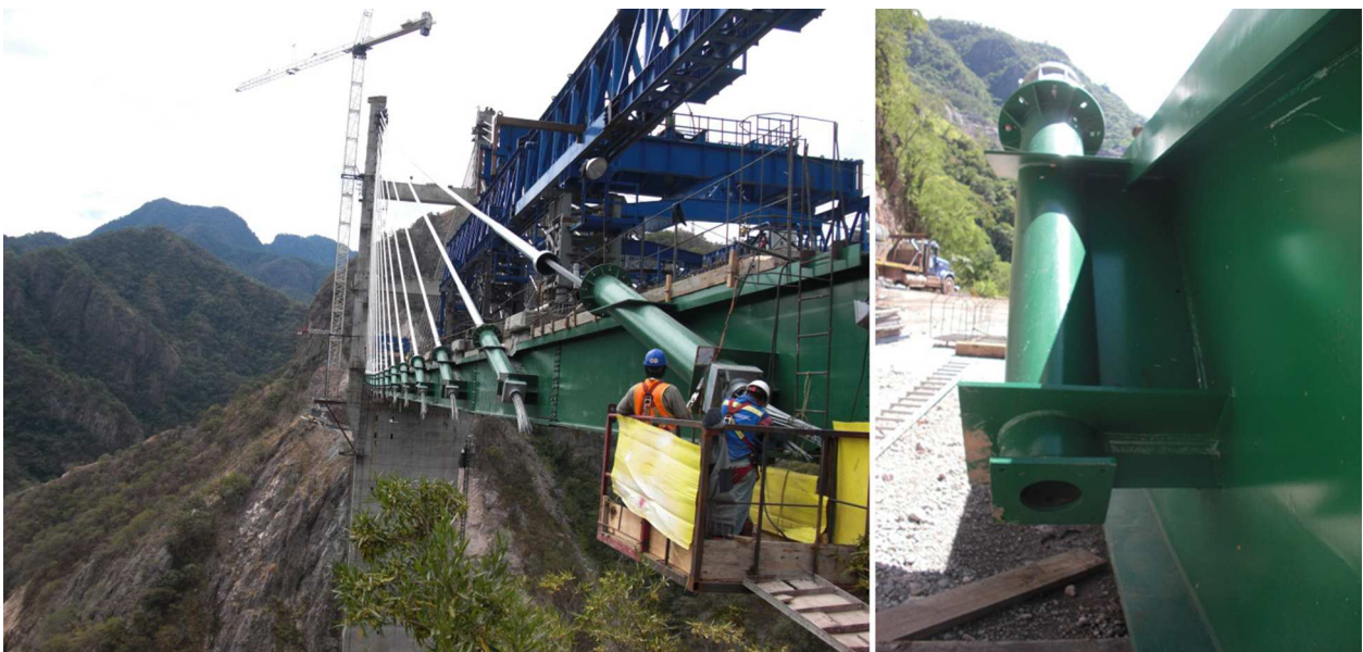
Figura 19. Acceso a anclajes en tablero. Tubos de tirante en dovela.
