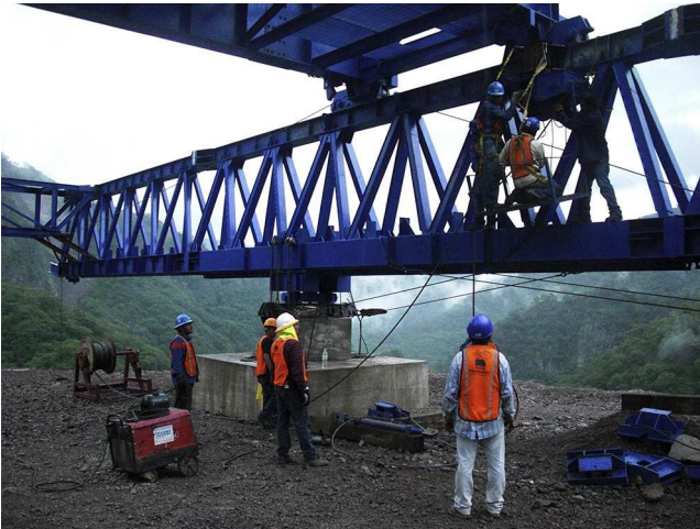
Figura 7. Pruebas de carga y funcionamiento de lanzadora completa a pie de pila.
