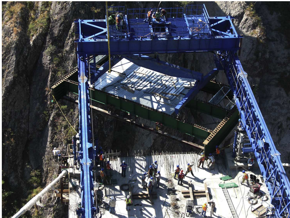
Figura 12. Giro de dovela en voladizo.
