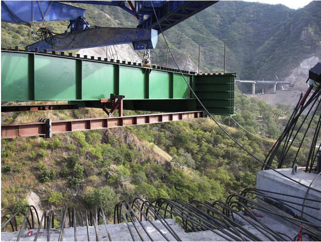
Figura 18. Dóvela con escantillón, orejetas y balancines.
