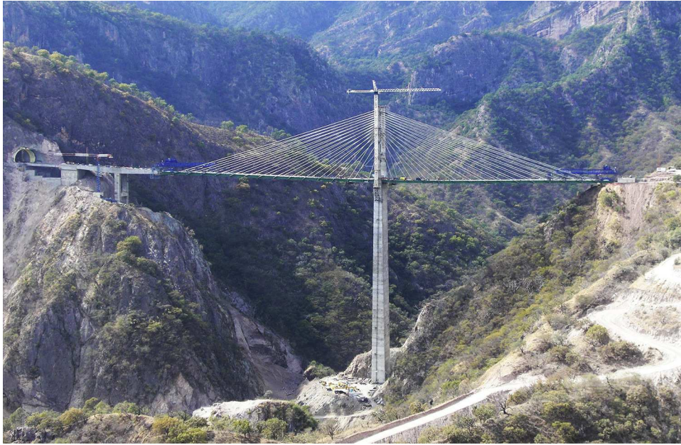
Figura 2. Vista general del puente y su entorno.
