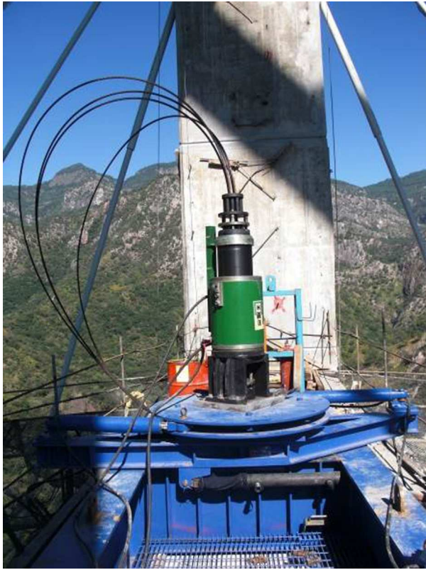
Figura 13. Mesa de giro con gato tragacables.
