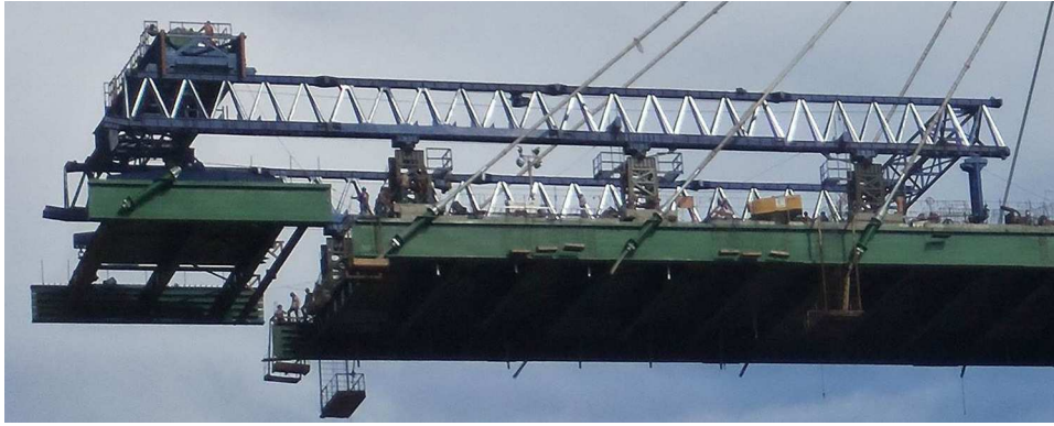
Figura 16. Disposición de apoyos de lanzadora sobre tablero.
