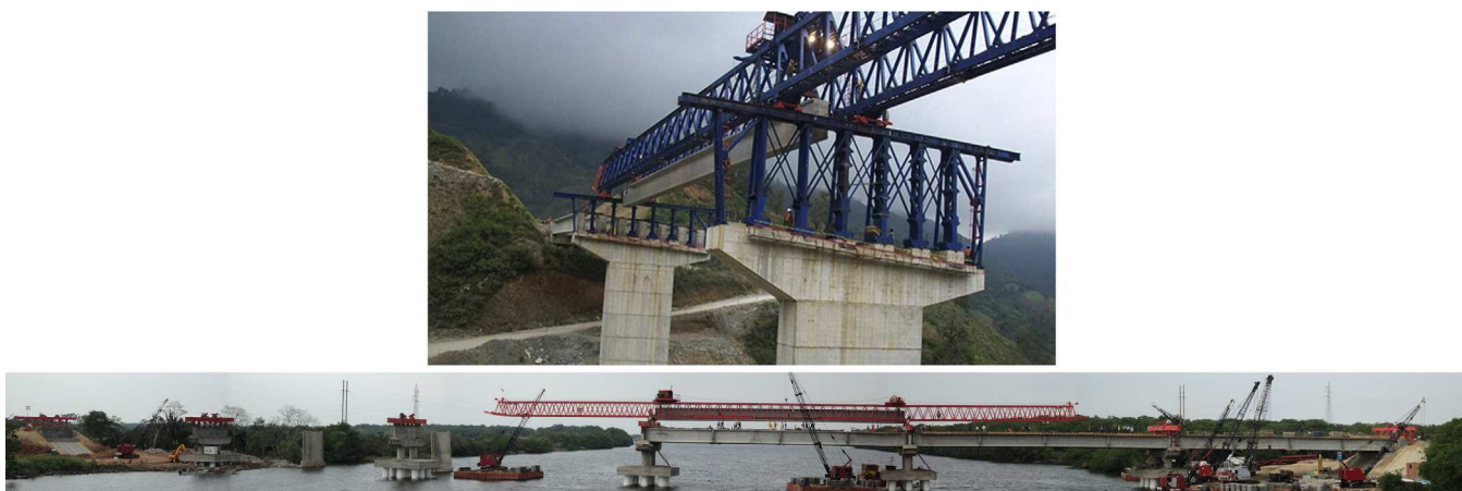
Figura 4. Lanzadoras convencionales en ejecución de puentes de vigas (puentes El Cantil y Tonalá).
