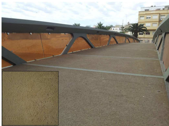
Figura 29. Textura de las losas superficiales.
