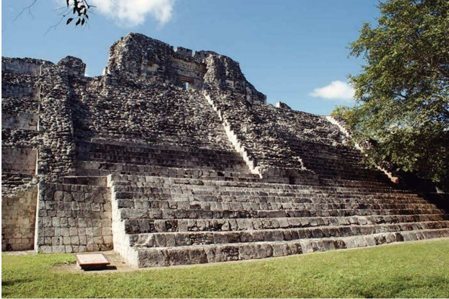
FIGURA 22. Estructura X, vista frontal. Becán, Campeche. Fotografía de la autora.
