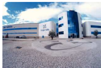
Almacén central del Grupo Safa en Zaragoza.
