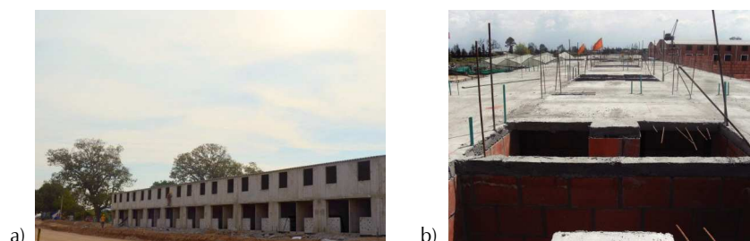
Figura 1. Construcción de VIS en Colombia, a) muros de concreto (Botero, 2013), b) mampostería confinada (Gómez, 2013)
