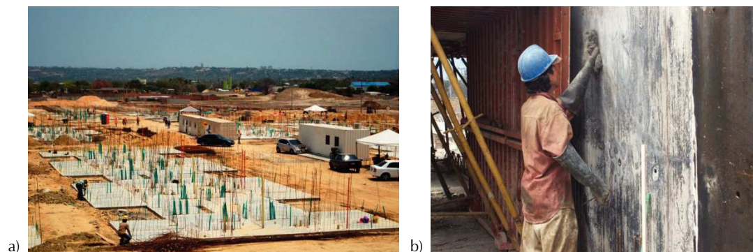
Figura 4. Construcción con muros de concreto en Colombia, a) cimentación (Osorio, 2013), b) muros de concreto ( 360^\circ en Concreto, 2013)
