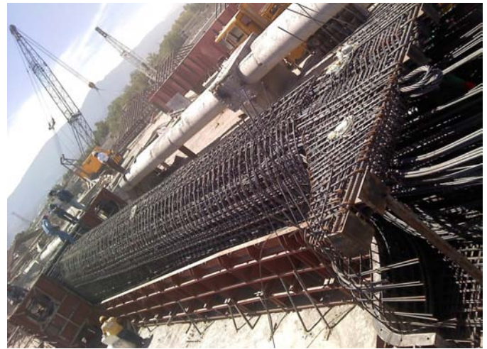
Instrumentación de una zapata-columna prefabricada pretensas
