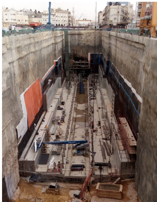
Figura 19. Módulos 1 a 3 de la contrabóveda finalizados.
