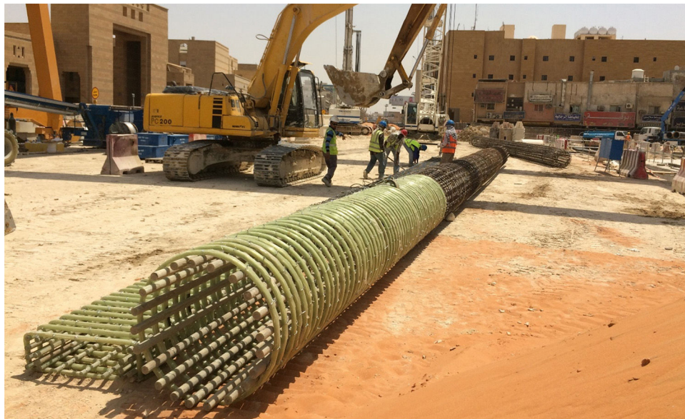
Figura 6. Armadura de fibra de vidrio.
