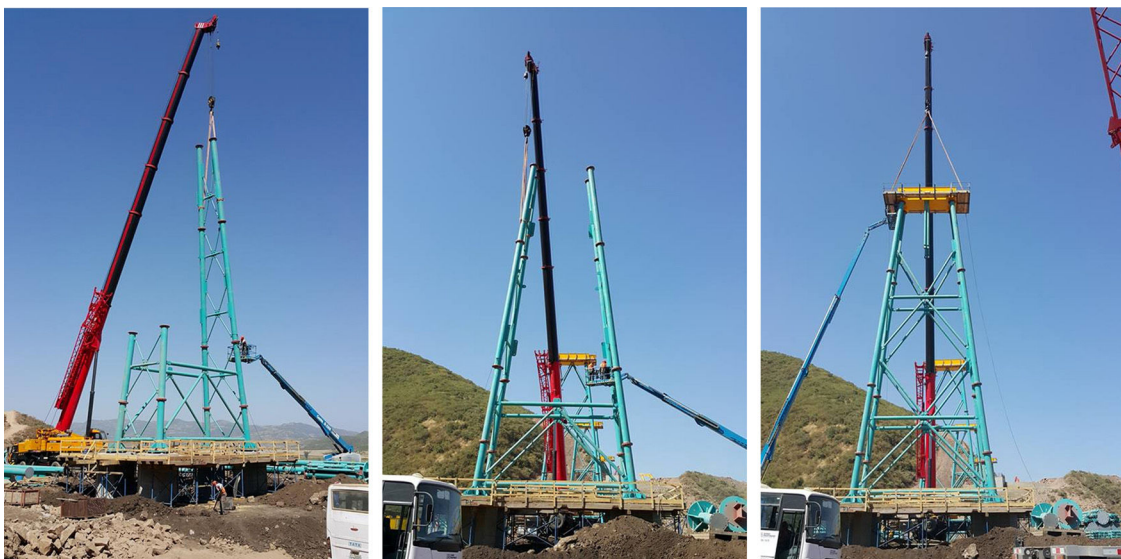
Figura 3. Montaje de las pilas in situ.
