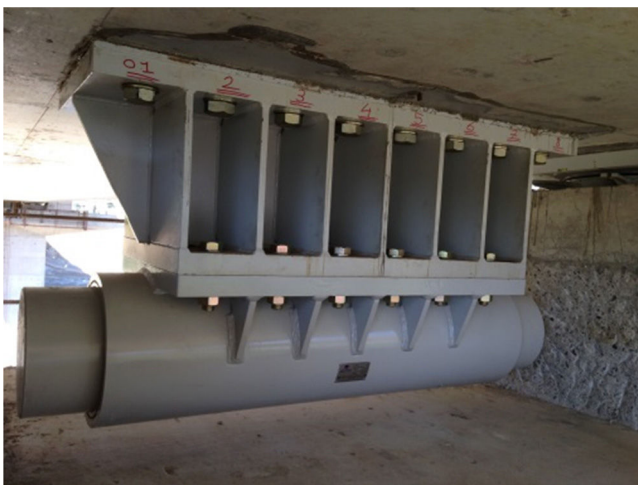
Figura 8. Ejemplo de dispositivo sísmico tipo PDS.
