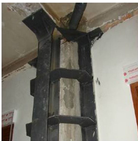
Figura 10. Detalle de refuerzo de capitel [8].
