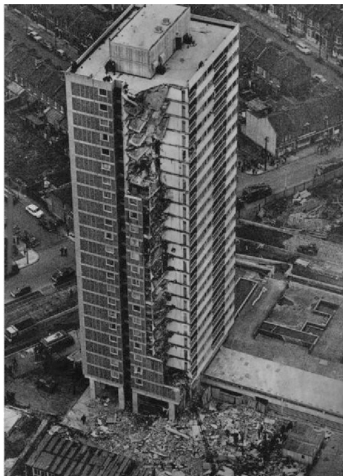
Figura 1. Hundimiento parcial de la torre Ronan Point el 16 de mayo de 1968. Londres. Fuente Levy y Salvadori [2].
