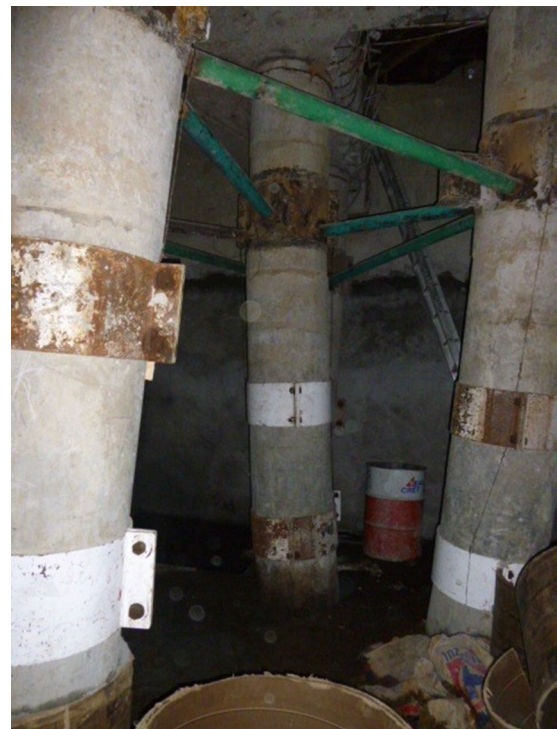
Figura 14. Pilotes inclinados.
