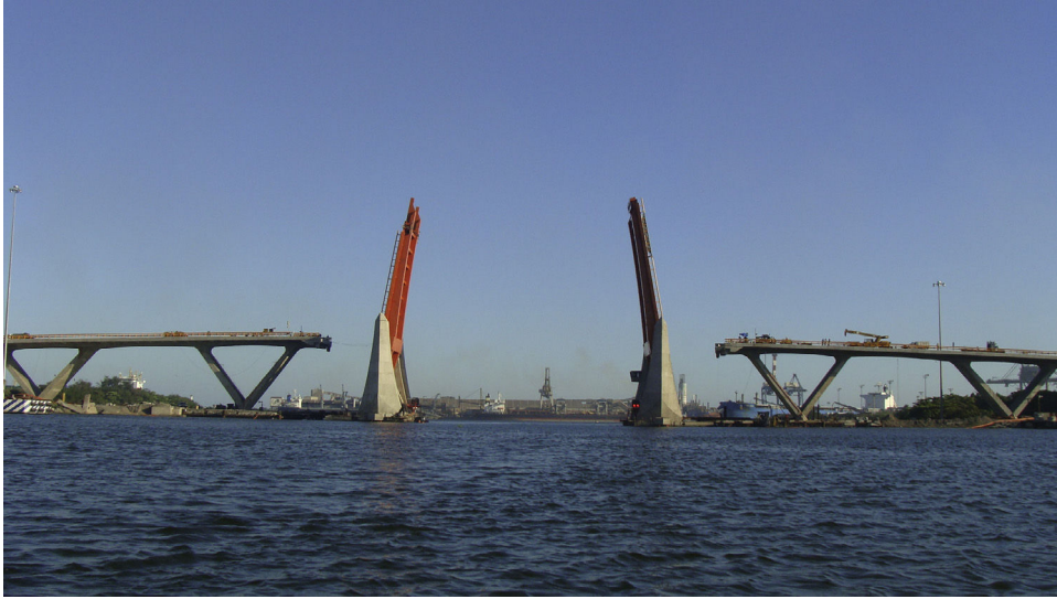
Figura 3. Puente Albatros. Tramo basculante.
