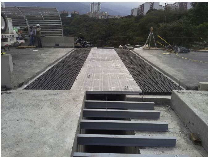
Figura 8. Vista de la junta durante su instalación.
