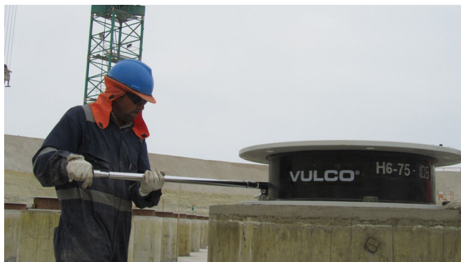
Figura 11. Apriete de los pernos inferiores de anclaje.
