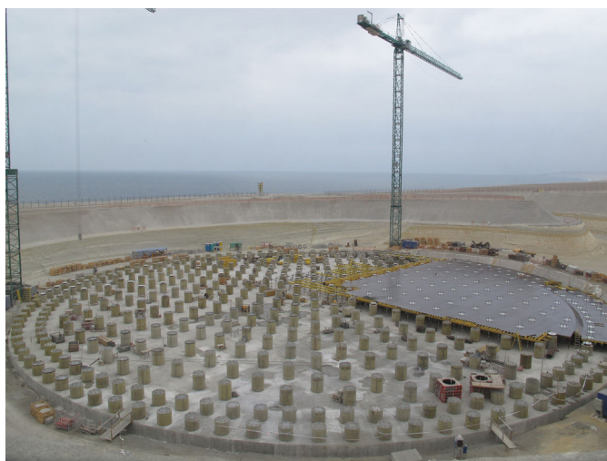
Figura 12. Vista general de los pedestales y aisladores durante la fase de construcción.
