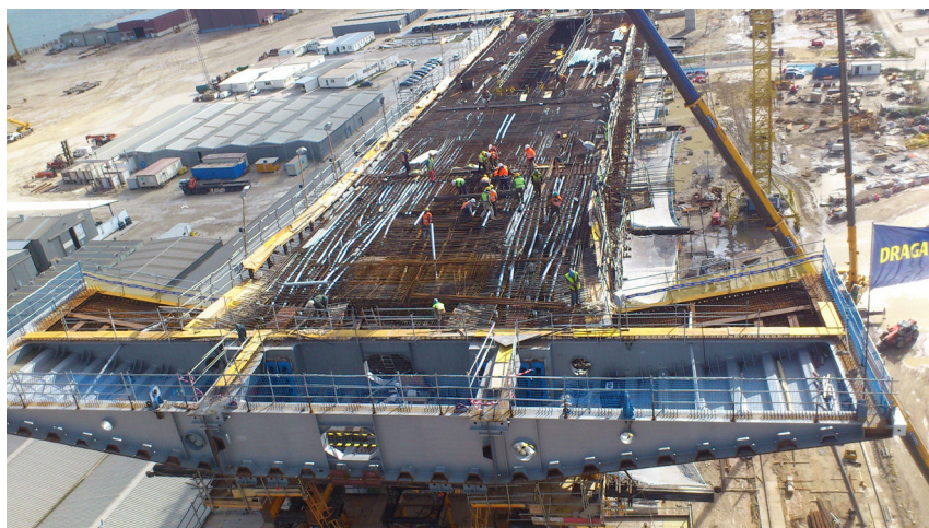
Figura 21. Dodela de transición (17DP13) con el tramo de núcleo ferrallado, previo al hormigonado.
