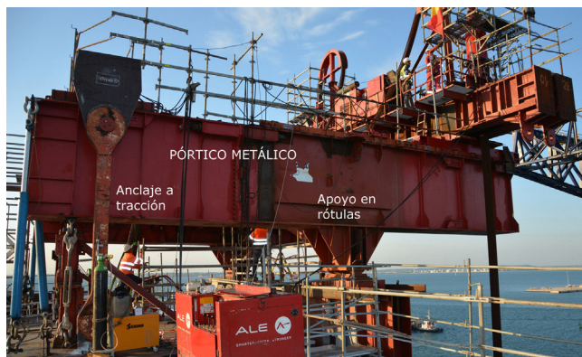
Figura 15. Pórtico de izado situado sobre la pila 10 y anclado al tramo desmontable.
