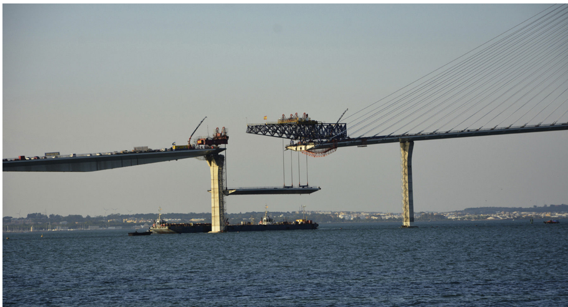
Figura 14. Izado de la dovela 16IP12.
