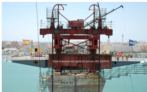
Figura 15. Pórtico de izado situado sobre la pila 10 y anclado al tramo desmontable.
