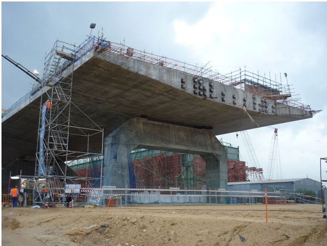
Figura 5. Frente de anclajes en cambio de fase.
