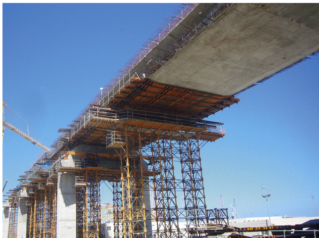
Figura 9. Núcleo cimbrado de la sección en ejecución.
