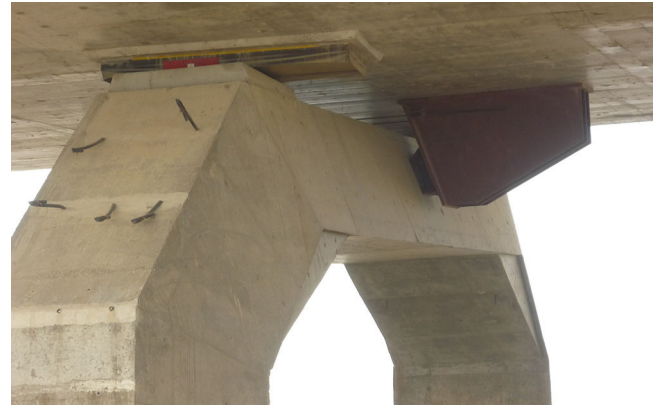
Figura 6. Detalle del tope longitudinal pila-tablero dispuesto.
