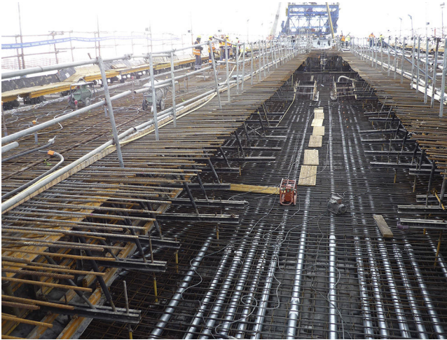
Figura 15. Detalle de ejecución del núcleo.
