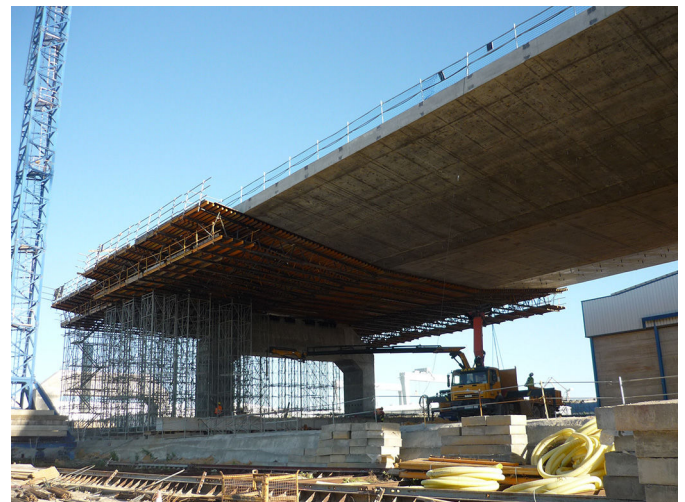
Figura 4. Descimbrando en fase de ejecución.
