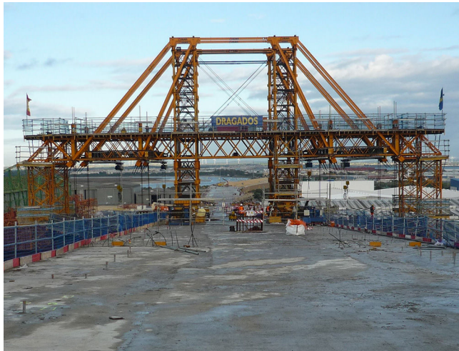
Figura 20. Vista superior del carro de alas.
