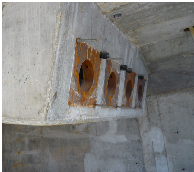
Figura 12. Anclajes pretensado en segunda fase.
