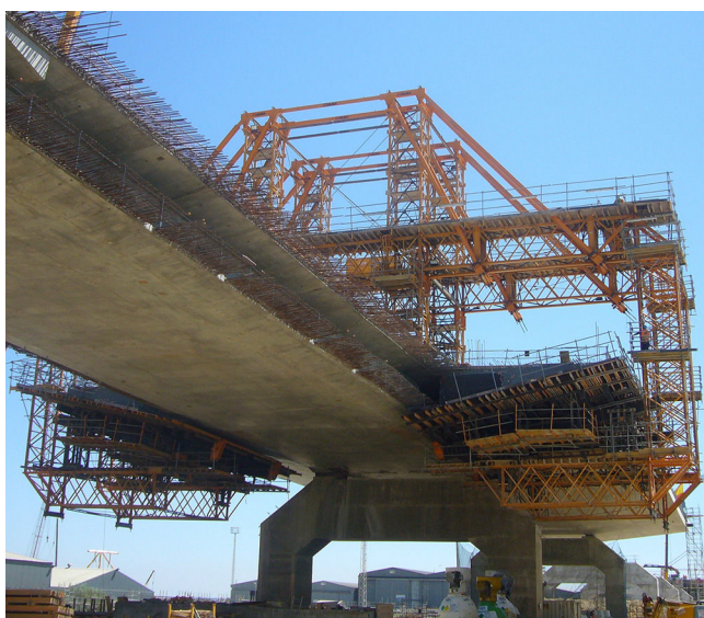
Figura 10. Voladizos exteriores ejecutados con carro.
