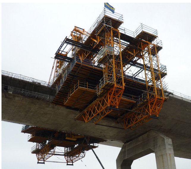
Figura 21. Vista inferior del carro de alas.
