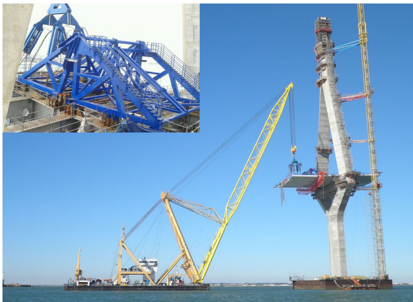
Figura 10. Elemento especial para colocación de dovelas iniciales.
