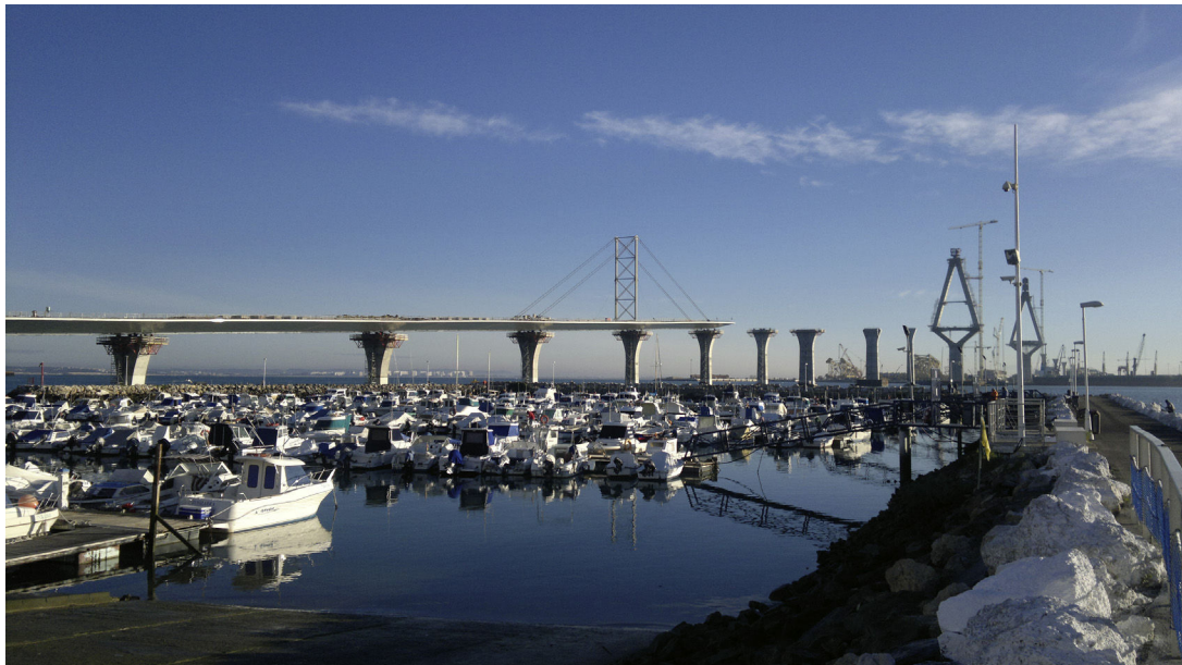
Figura 5. Puente de acceso desde Cádiz. Proceso de empuje de la parte metálica.
