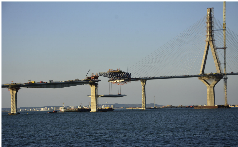
Figura 7. Cierre lateral con el puente desmontable.
