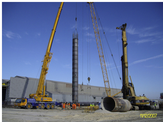
Figura 3. Introducción de la armadura y camisa perdida.
