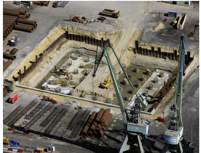
Figura 5. Imagen aérea de la excavación para la ejecución del encepado de la pila 13 (pilón principal en muelle de La Cabezuela).
