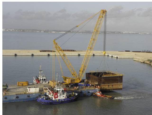
Figura 5. Transporte de los recintos tipo 1 a 3.
