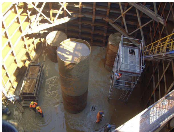
Figura 8. Recinto tras achicado, antes de descabezar pilotes.
