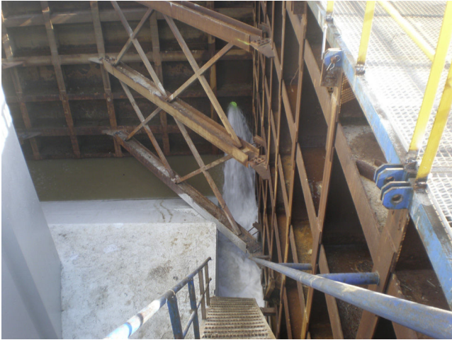
Figura 10. Inundación del recinto previa a desmontaje.
