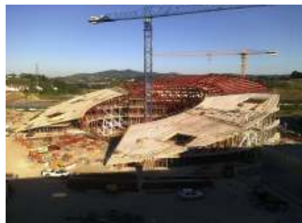
Figura 11. Ejecución del forjado de cubierta.
