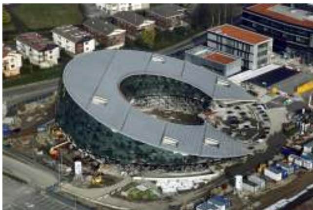
Figura 4. Vista superior de la cubierta.
