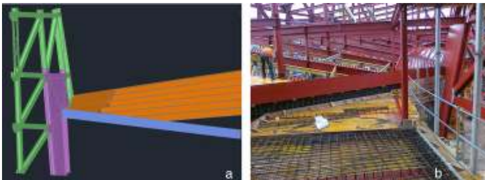
Figura 19. Refuerzo de chapa en el forjado de fondo. Imagen de la modelización 3D (a) y fotografía de la ejecución (b).
