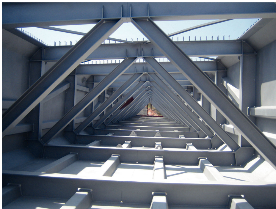
Figura 1. Sección formada por placas esbeltas rigidizadas.
