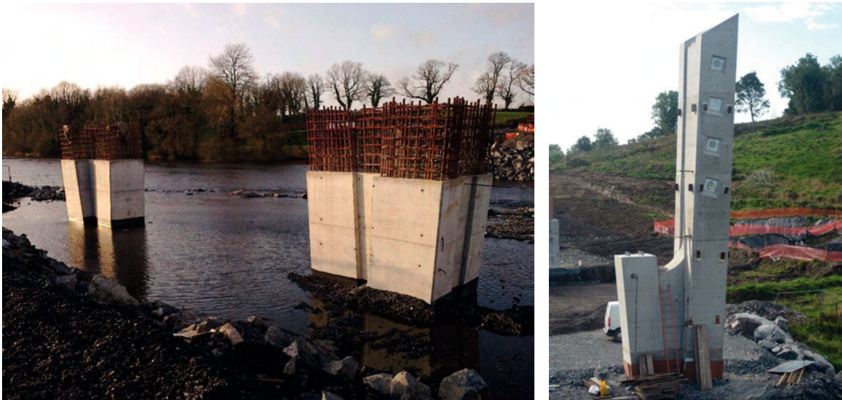
Figura 12. Vista de los pilonos en ejecución.
