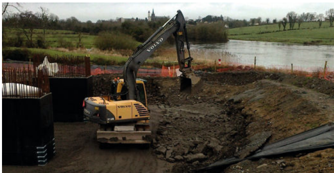
Figura 10. Estribo norte en ejecución.
