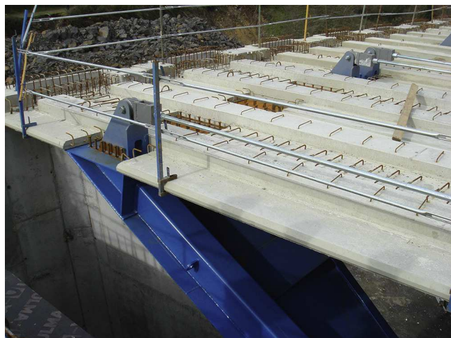
Figura 14. Viaducto principal. Prelas colocadas.
