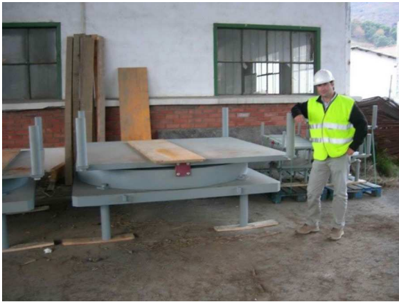
Figura 26. Imagen de los apoyos tipo POT.
