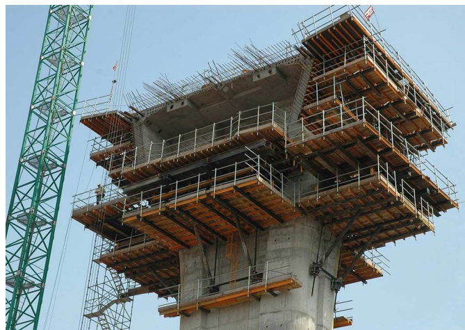
Figura 8. Plataformas de trabajo de dovela cero.
