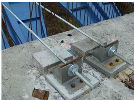
Figura 13. Viaducto principal. Tacos de sujeción en núcleo.
