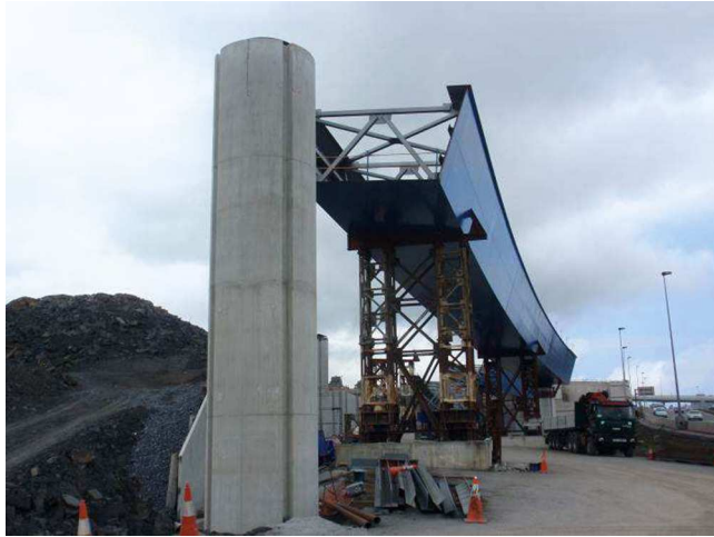
Figura 28. Pilas de los ramales de acceso.
