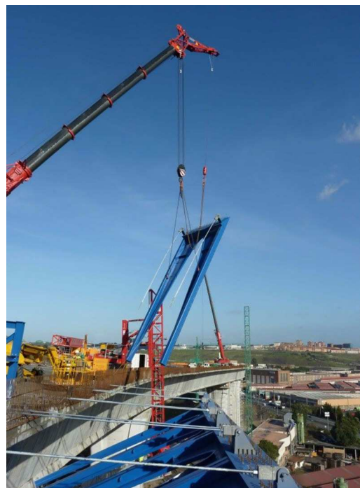
Figura 15. Viaducto principal. Montaje de jabalcones.
