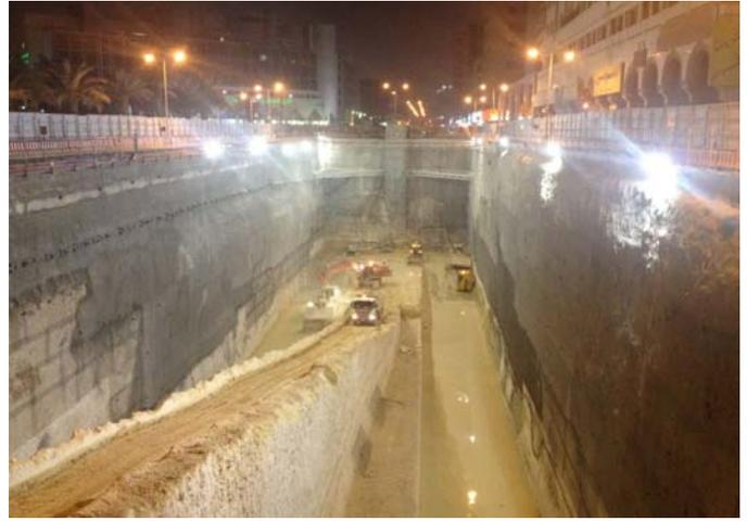
Excavación parcial con sostenimiento del propio terreno
