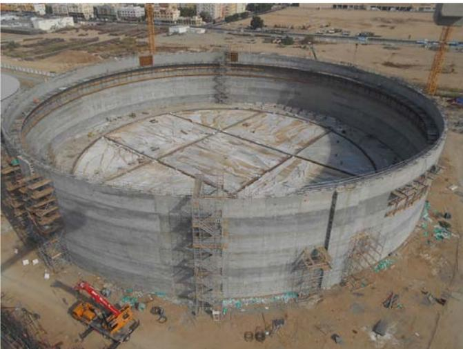
Depósito de hormigón postesado de Faisaliyah, con capacidad para 250.000 m<sup>3</sup>/tanque
