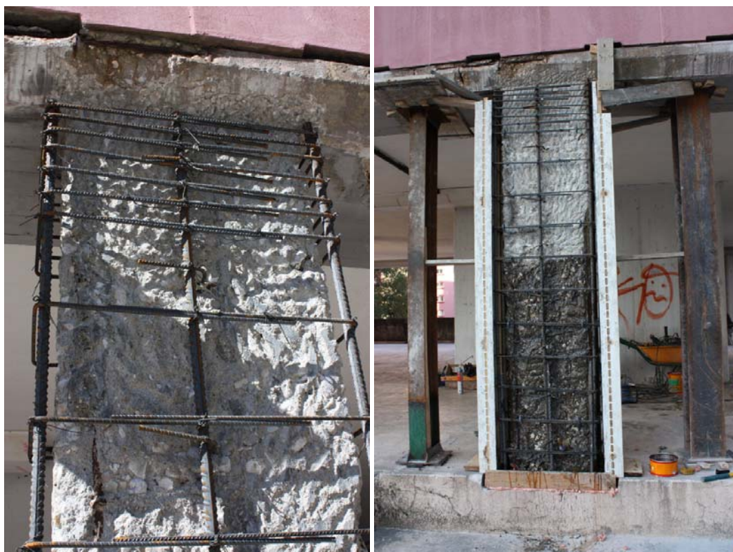
Figura 6. Refuerzo de pilar apantallado.
