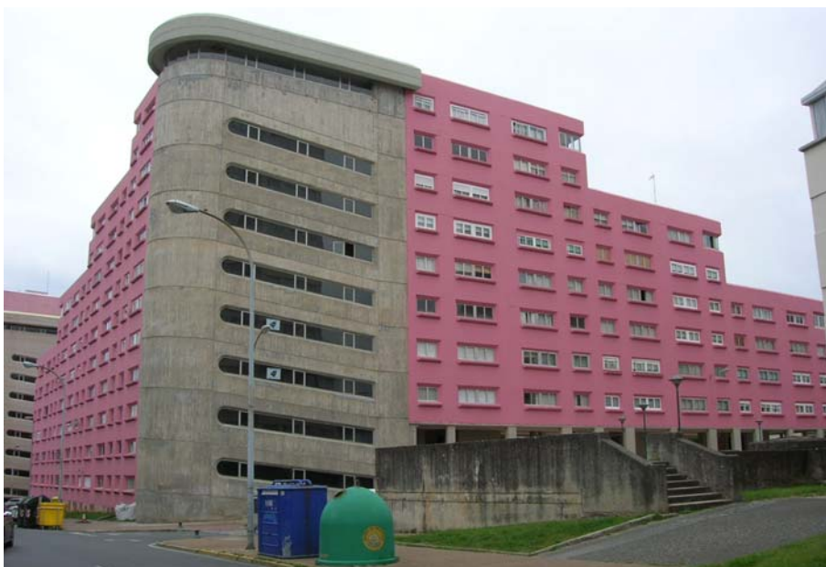
Figura 8. Bloque L6 tras la intervención.
