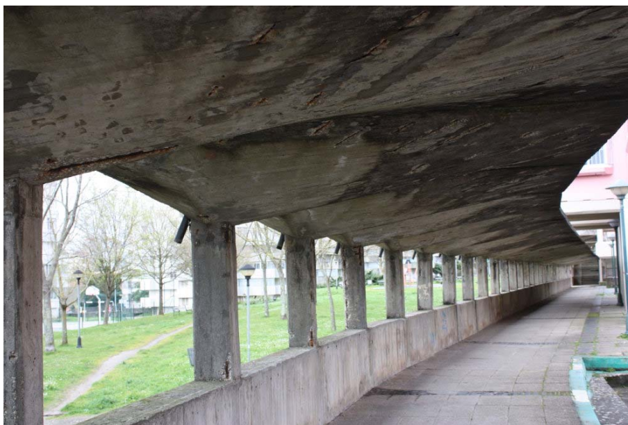
Figura 7. Paso cubierto con paraboloides disimétricos.
