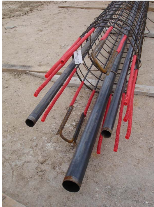
Figura 7. Armadura de pilotes con tubos para ensayos sísmicos
