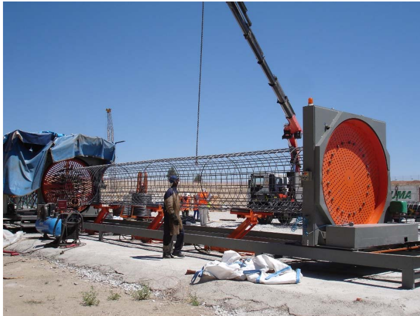
Figura 5. Fabricación de armadura de los pilotes
