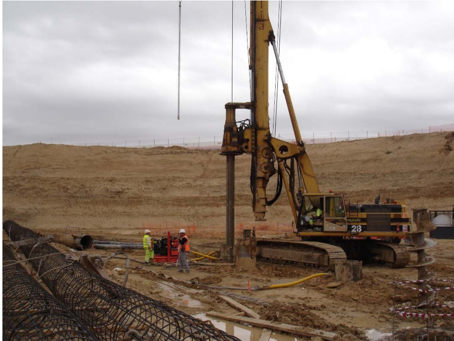
Figura 6. Ejecución de pilotes “in situ”
