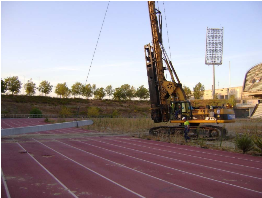
Figura 3. Ensayo de hincado de pilotes prefabricados
