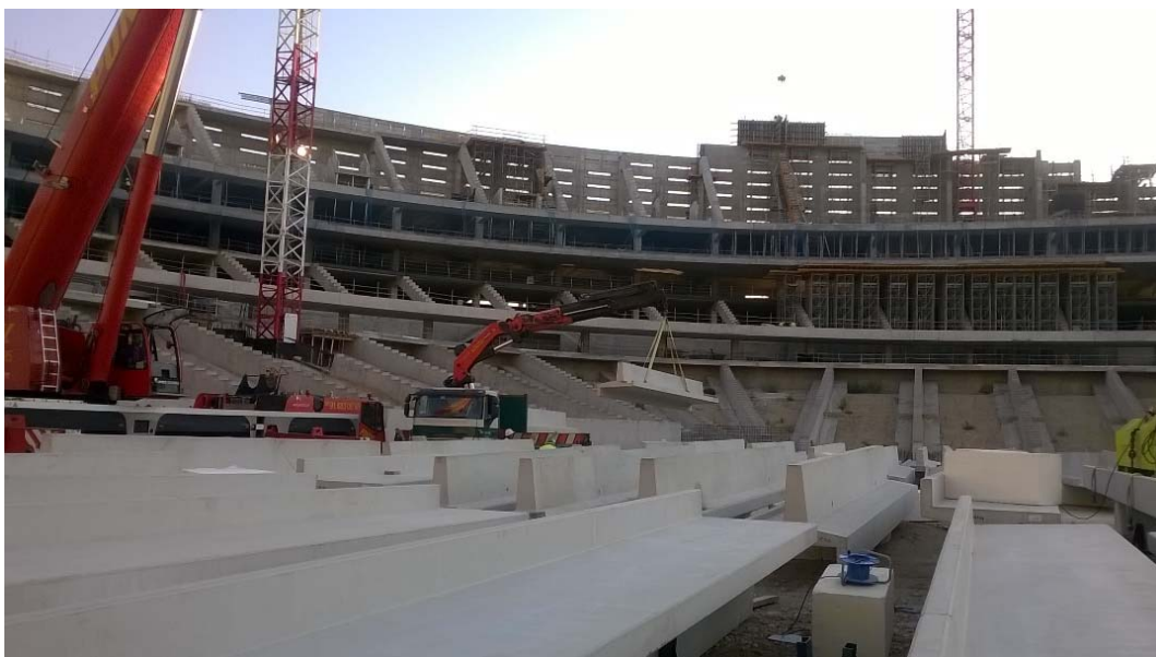
Figura 8. Montaje de gradas en obra
