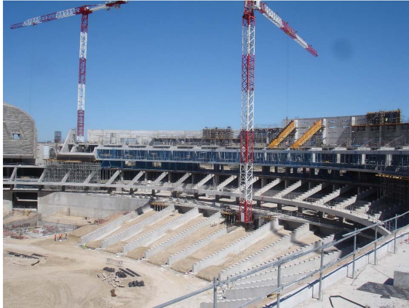
Figura 3. Portagradas de zona Norte. Nivel alto en construcción
