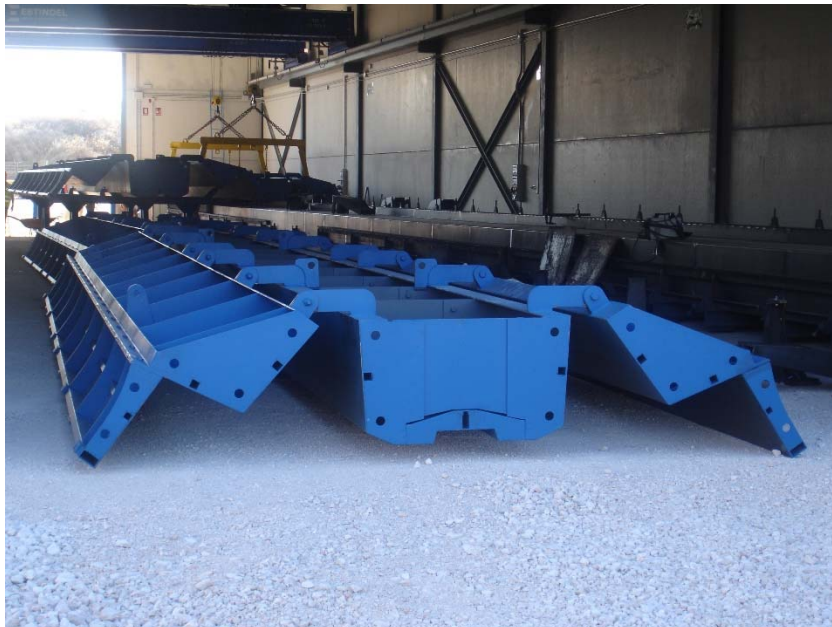
Figura 5. Nave de prefabricación de gradas en obra. Encofrado de doble grada tipo
