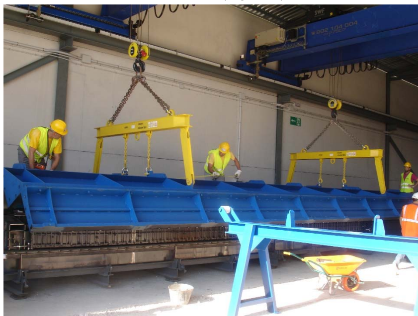
Figura 7. Montaje de caparazón exterior del encofrado
