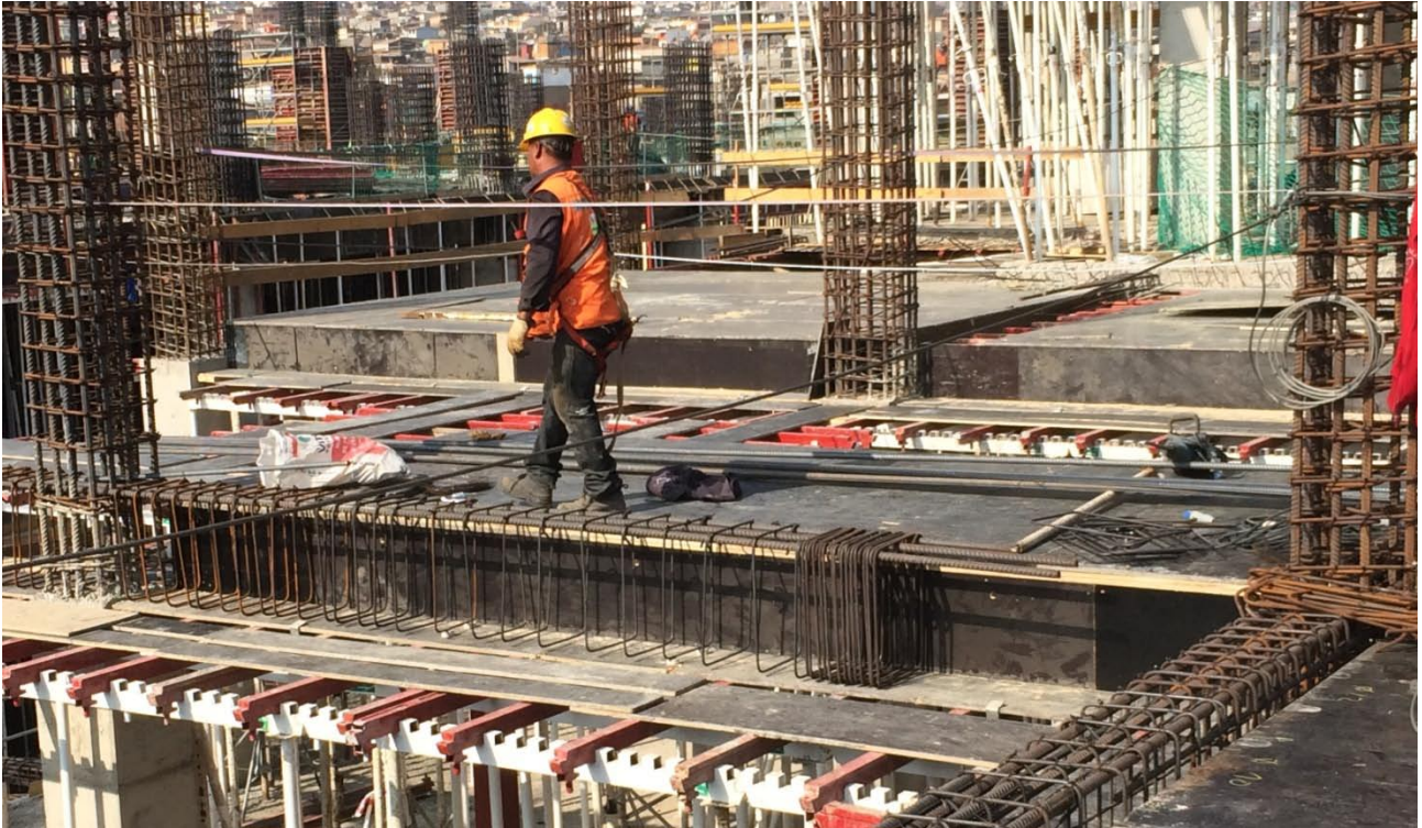
Figura 16. Ferrallado de viga de marco
