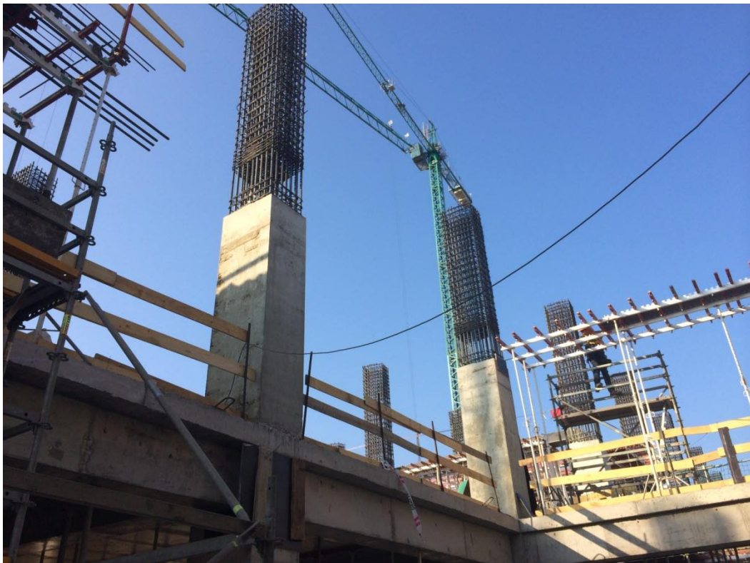
Figura 17. Detalle de ferralla de columnas
