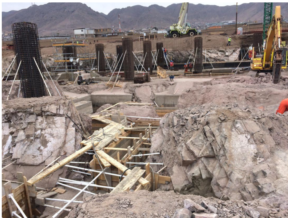
Figura 11. Excavación de fundaciones
