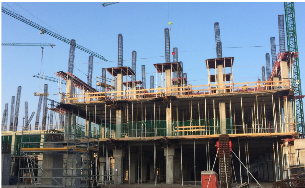
Figura 15. Sección por el CDT. Se aprecian los aisladores, el encofrado de losas con ábacos y la ferralla sobresaliente de las columnas
