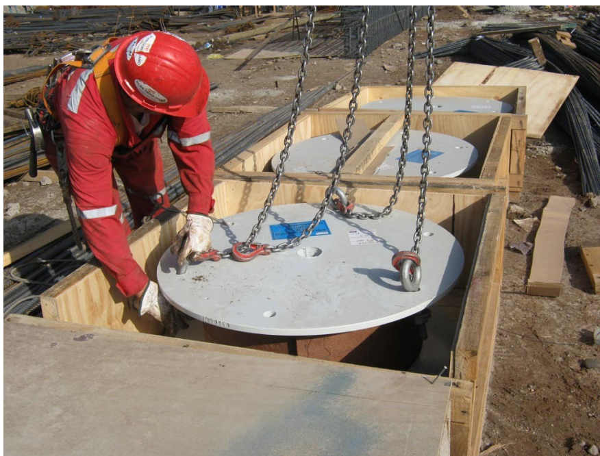
Figura 12. Protección para transporte e izamiento mecánico de los dispositivos (imagen referencial)
