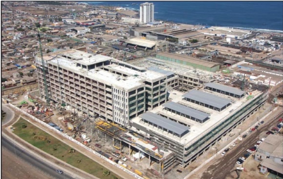
Figura 19. Conclusión de la estructura en el mes 15.
