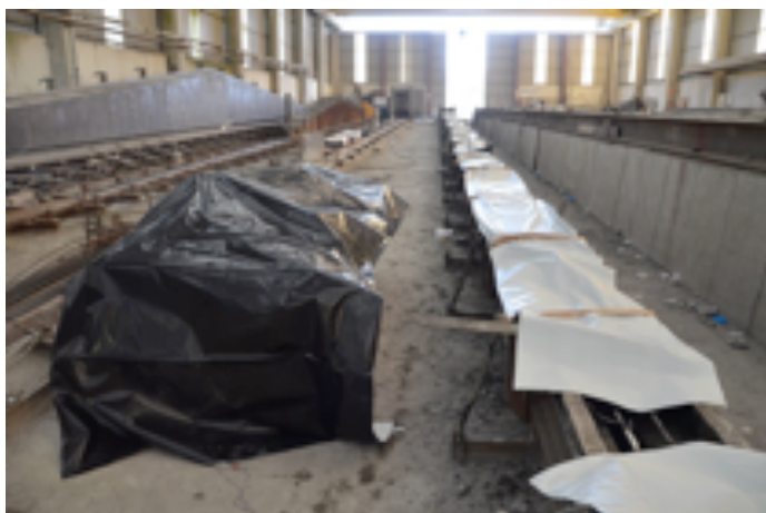
Figura 1. Fabricación de las vigas
