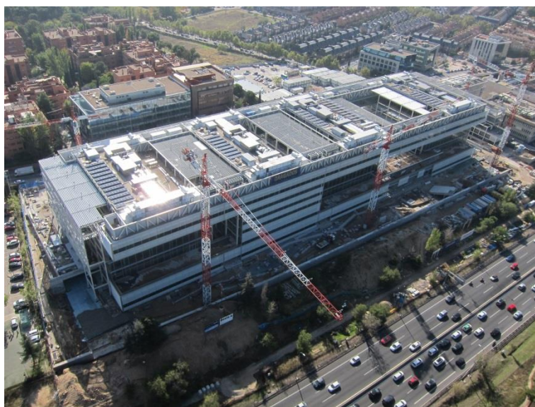
Figura 4. Vista general de la cubierta. Fachada norte. Agosto 2016.
