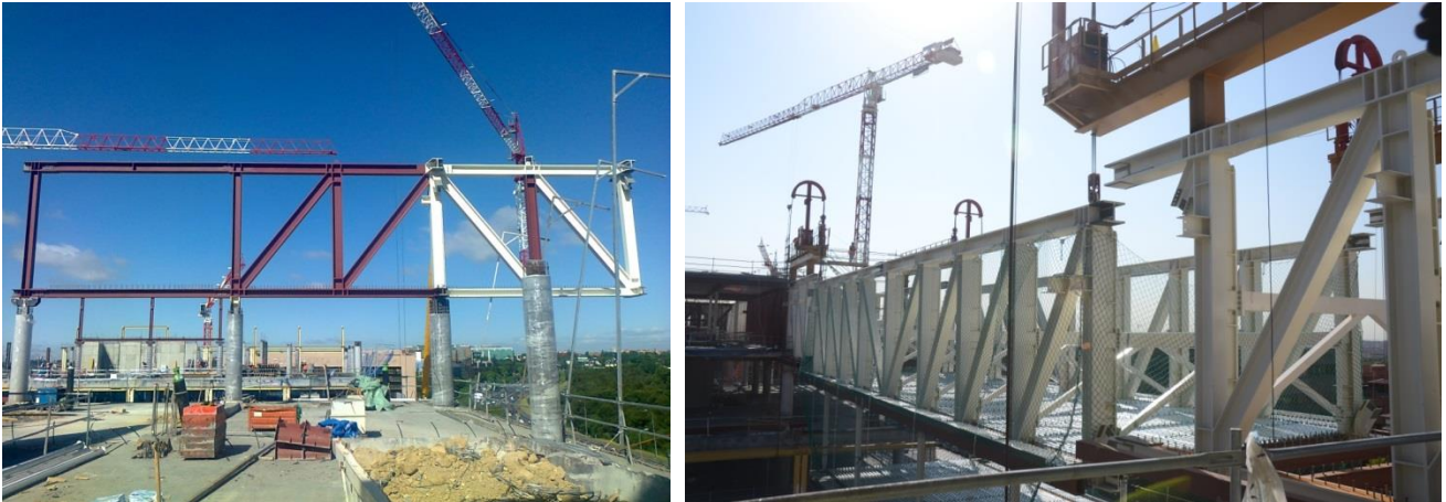
Figura 15. Montaje de celosías tipo A e izado de puente sur
