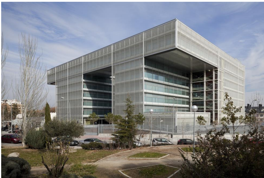
Figura 2. Edificio del Centro de Proceso de Datos en la calle Abelías (fase 1)
