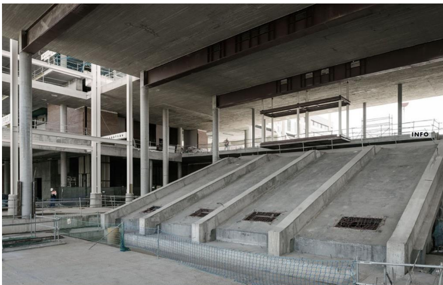
Figura 7. Graderío del salón de actos y cubierta sobre vigas mixtas
