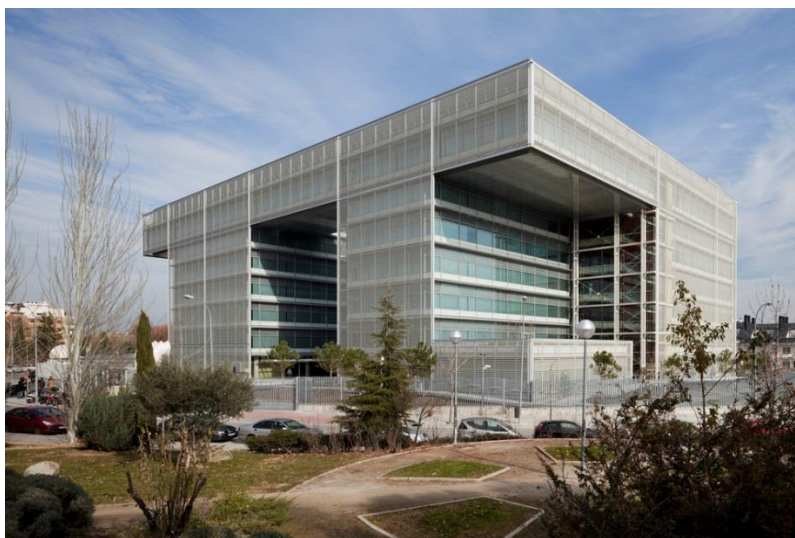
Figura 2. Edificio del Centro de Proceso de Datos en la calle Abelias (fase 1)
