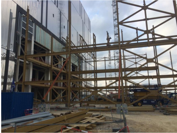
Figura 5. Construcción del RF Heating Building#15 (Noviembre de 2016).
