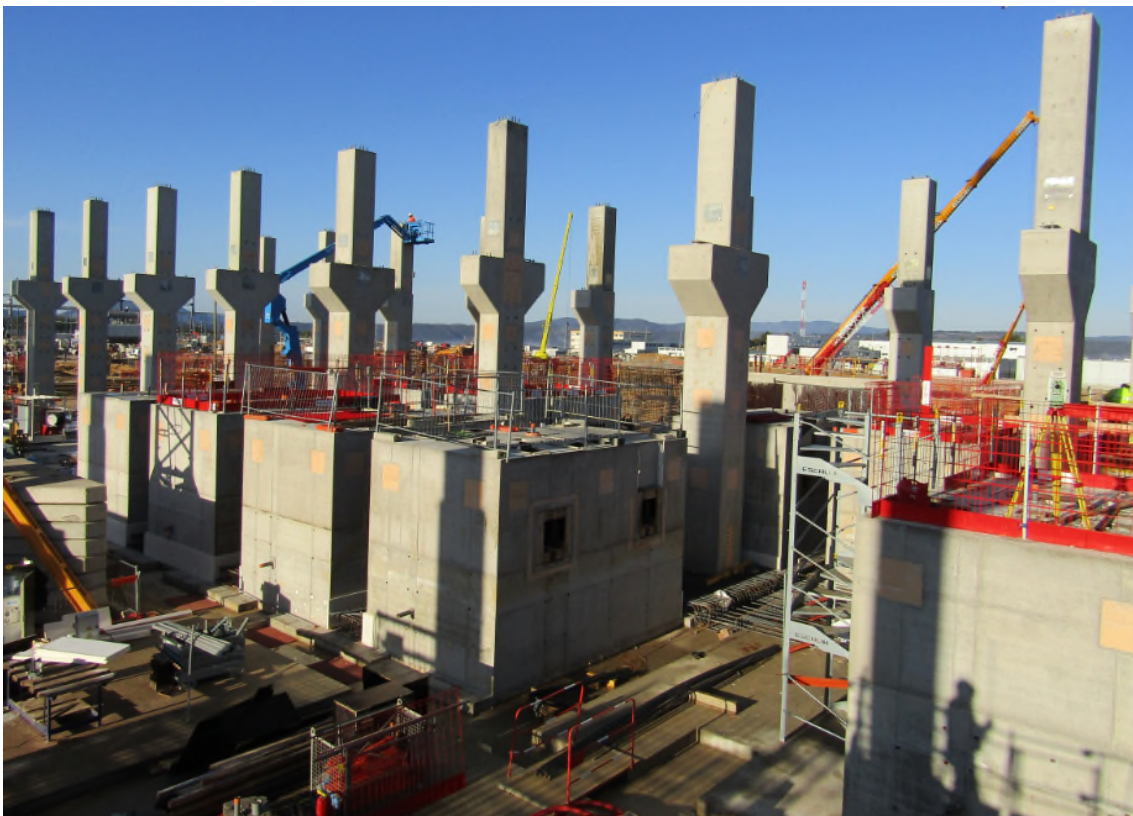
Figura 11. Vista actual de los bloques
