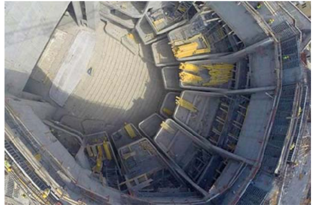
Figura 13. Gran Teatro – ejecución balcones (II)
