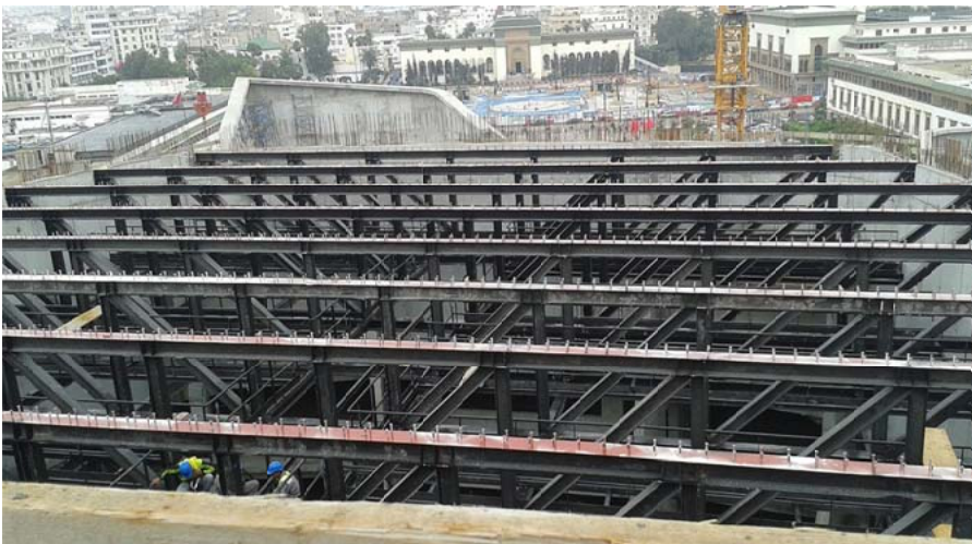
Figura 16. Gran Teatro – vistas de las cerchas mixtas de cubierta, por encima de la sala
