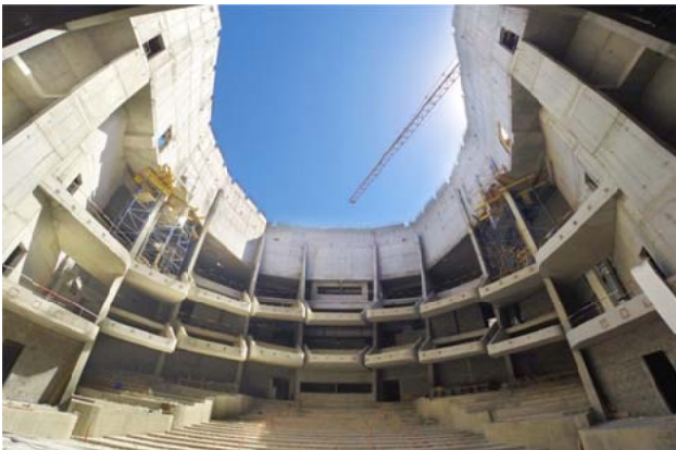
Figura 14. Gran Teatro – ejecución balcones (III)
