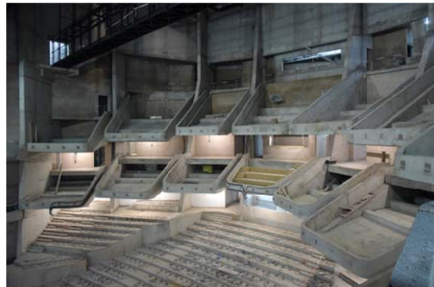
Figura 15. Gran Teatro – ejecución balcones (IV)
