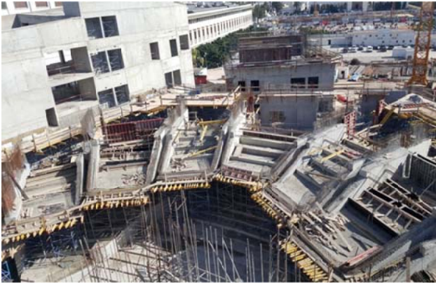
Figura 12. Gran Teatro – ejecución balcones (I)
