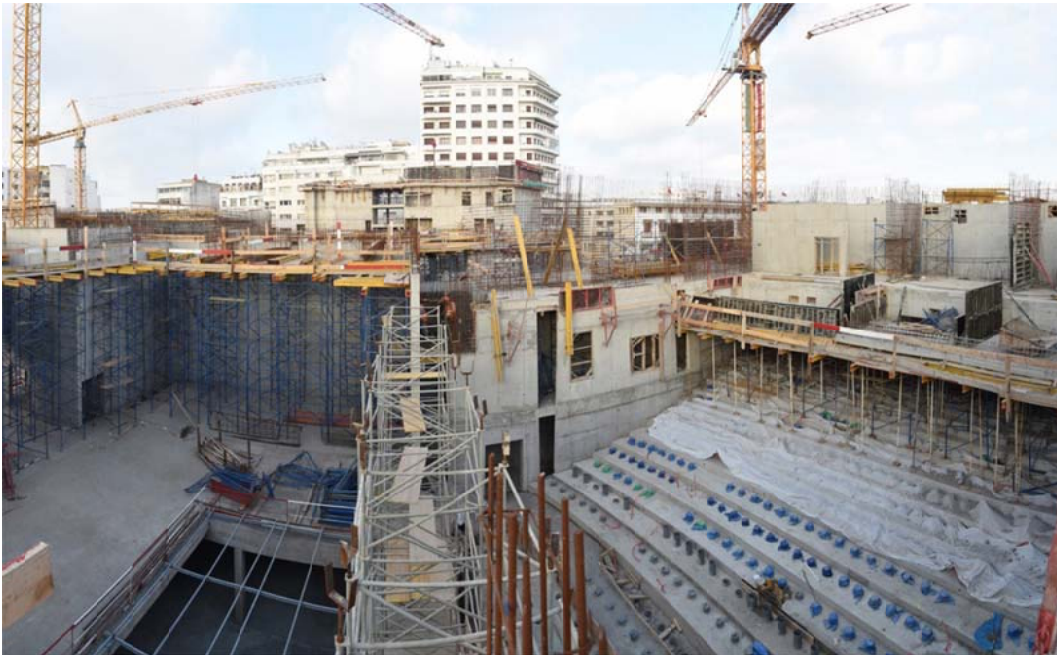
Figura 17. Pequeño Teatro – vista general durante la construcción
