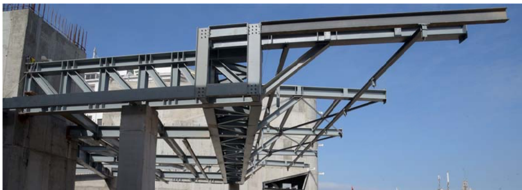
Figura 22. Pabellón de acceso – vista de la estructura de cubierta en construcción
