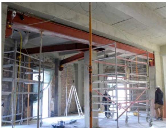
Figura 14. Vista del emparrillado metálico de transferencia de carga.
