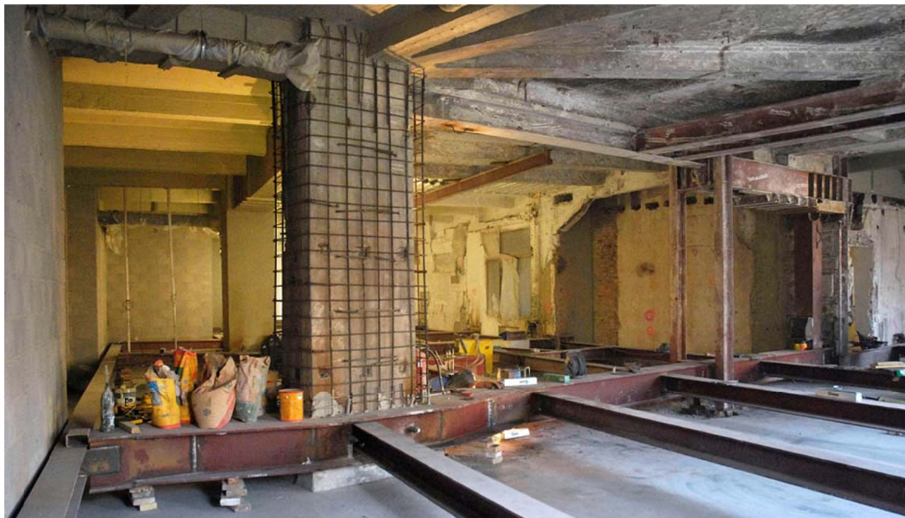
Figura 13. Apoyo, en el soporte, de la viga principal desdoblada en dos perfiles armados en “C”.
