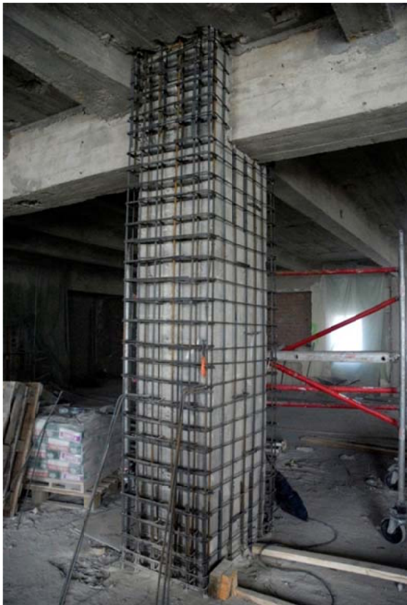
Figura 4. Armadura de zunchado de un soporte.
