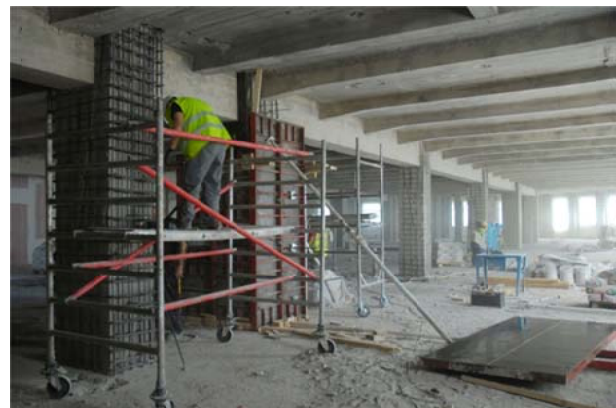
Figura 6. Armadura de zunchado y encofrado
