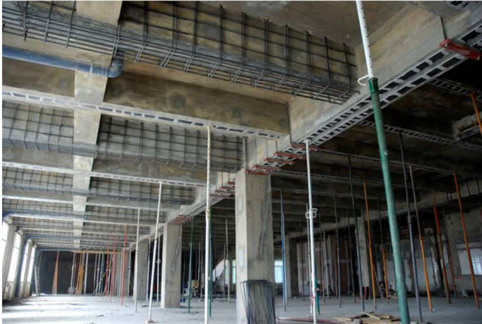
Figura 9. Vista, desde abajo, de una losa nervada reforzada.
