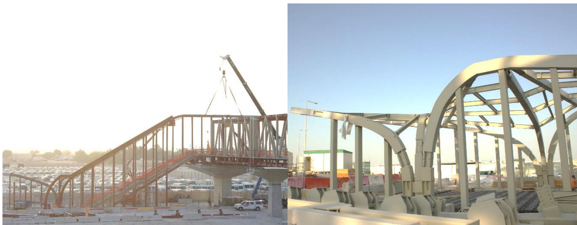
Figura 11. Cubierta de Shelter en Economic Zone y Al Wakra
