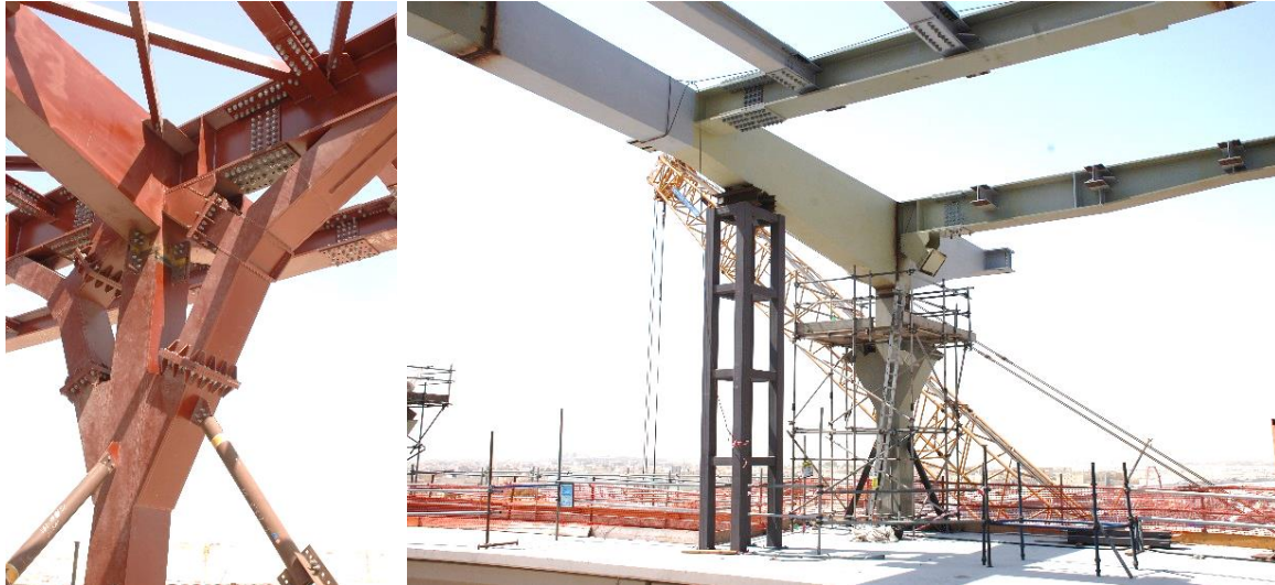
Figura 5. Uniones y montaje de las cubiertas
