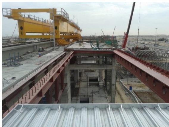
Figura 13. Viga lanzadora pasando por la estación de EZ
