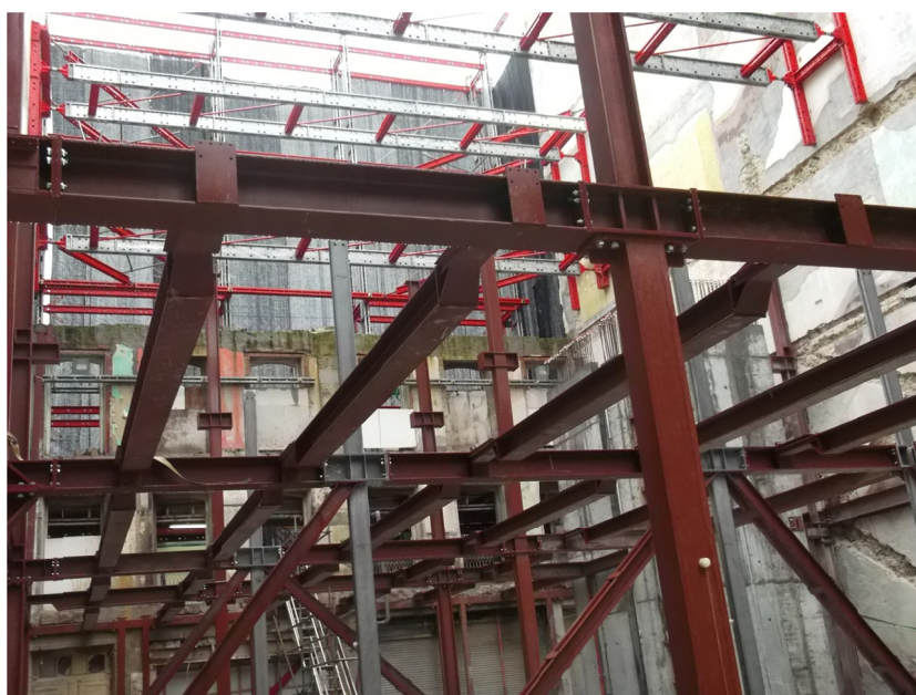
Figura 11. Ejecución de Estructura metálica
