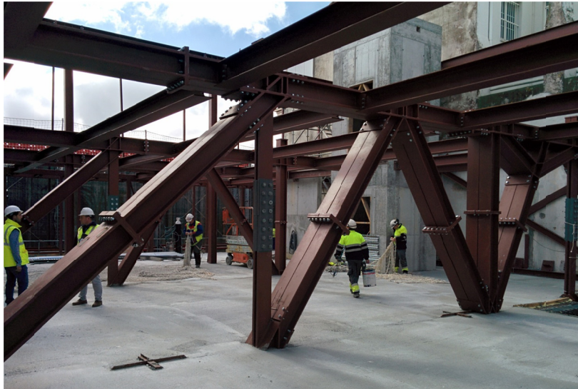
Figura 12. Ejecución de celosías en planta 5ª
