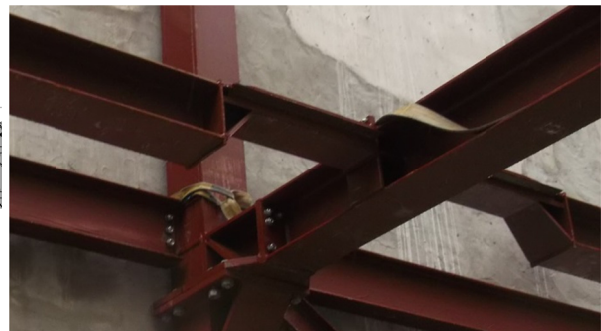
Figura 6. Detalle de conexión de vigas con reducción de canto
