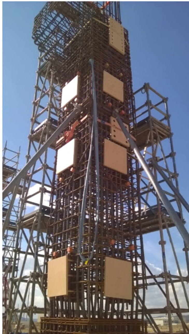
Figura 10. Placas embebidas solicitadas por el cliente para futuras conexiones.
