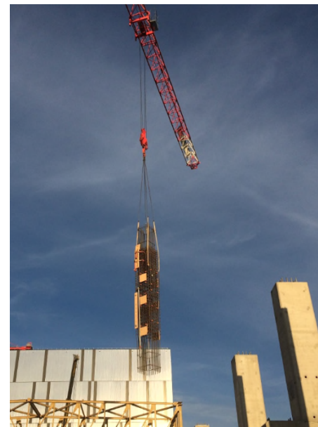
Figura 5. Rotación del armado del pilar y transporte a su posición final.
