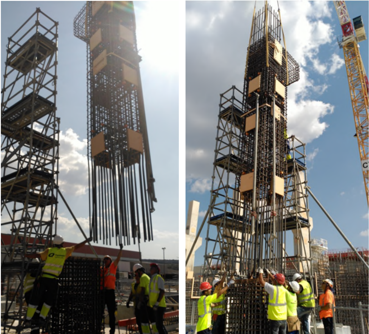
Figura 6. Colocación de armado de pilar en junta de hormigonado.
