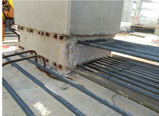
Figura 7. Sección del pilar en zona de conexión con la losa y foto de obra.
