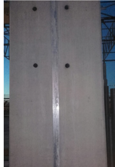
Figura 13. Railes para fijación de bandejas de fachada.
