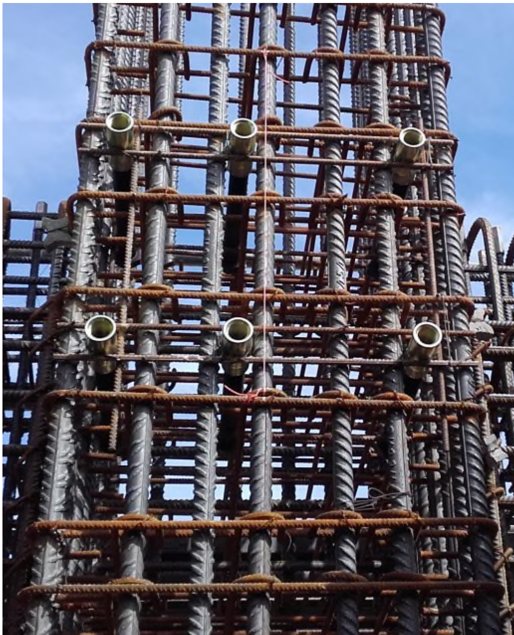
Figura 12. Anclajes para fijacion de tornillos instalados con la armadura.
