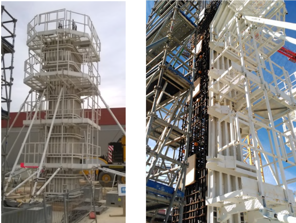
Figura 3. Encofrado de pilares.
