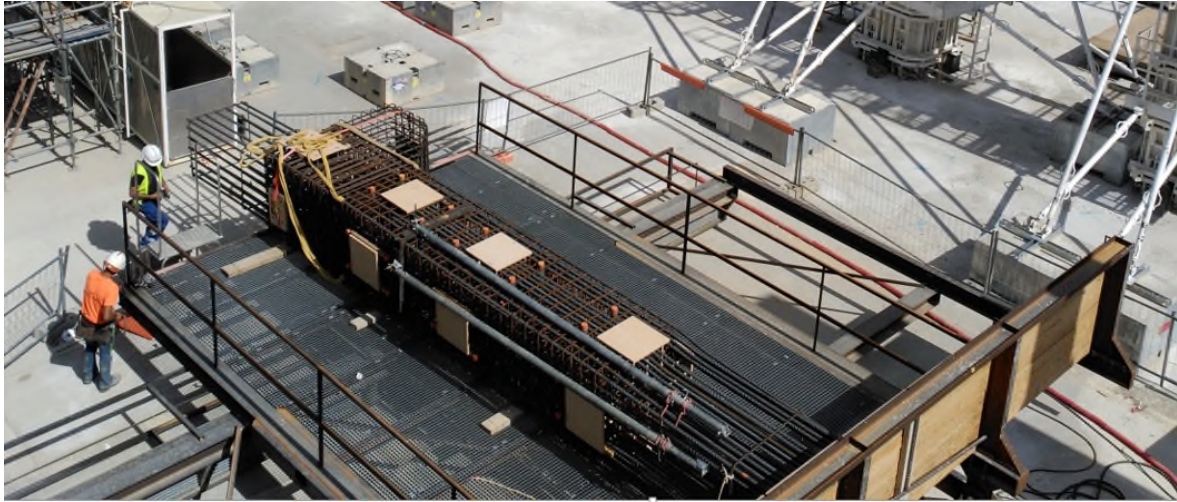
Figura 4. Plataforma basculante de preparación de armado del pilar.
