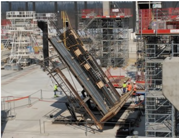
Figura 5. Rotación del armado del pilar y transporte a su posición final.
