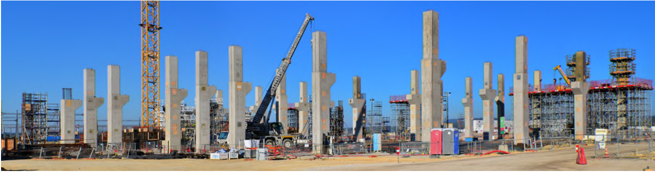
Figura 2. Vista general de la obra en construcción.
