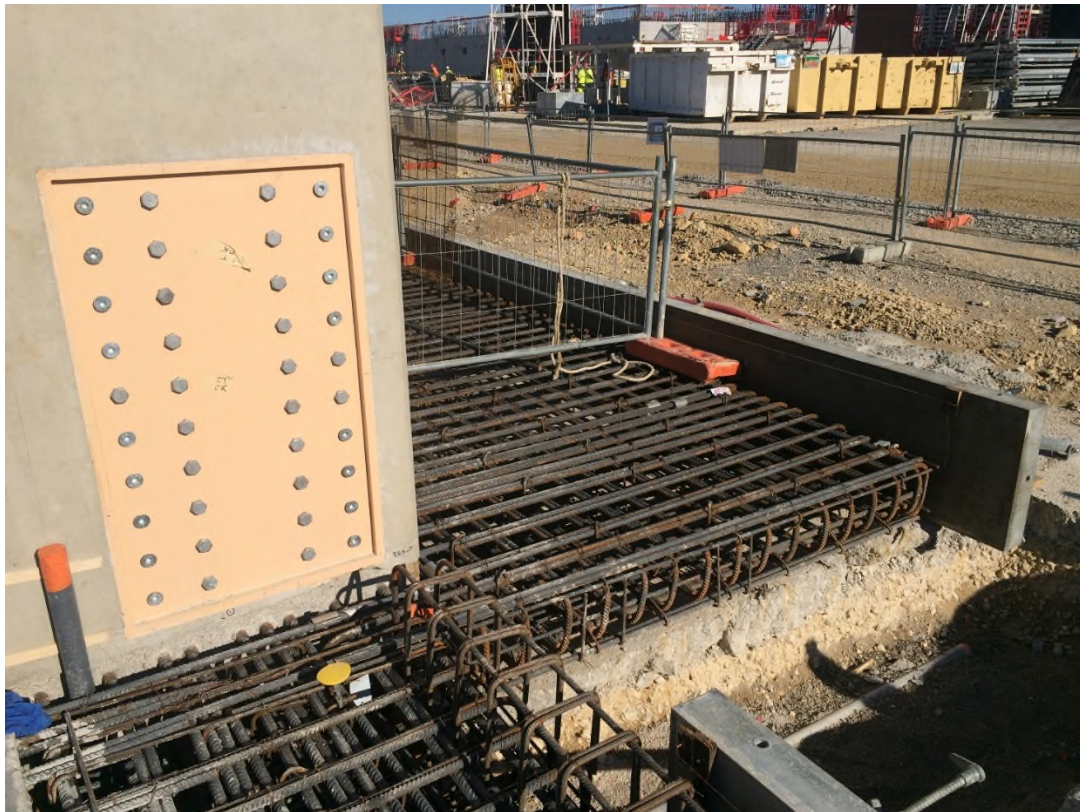
Figura 9. Colocación de armado de pilar en junta de hormigonado.
