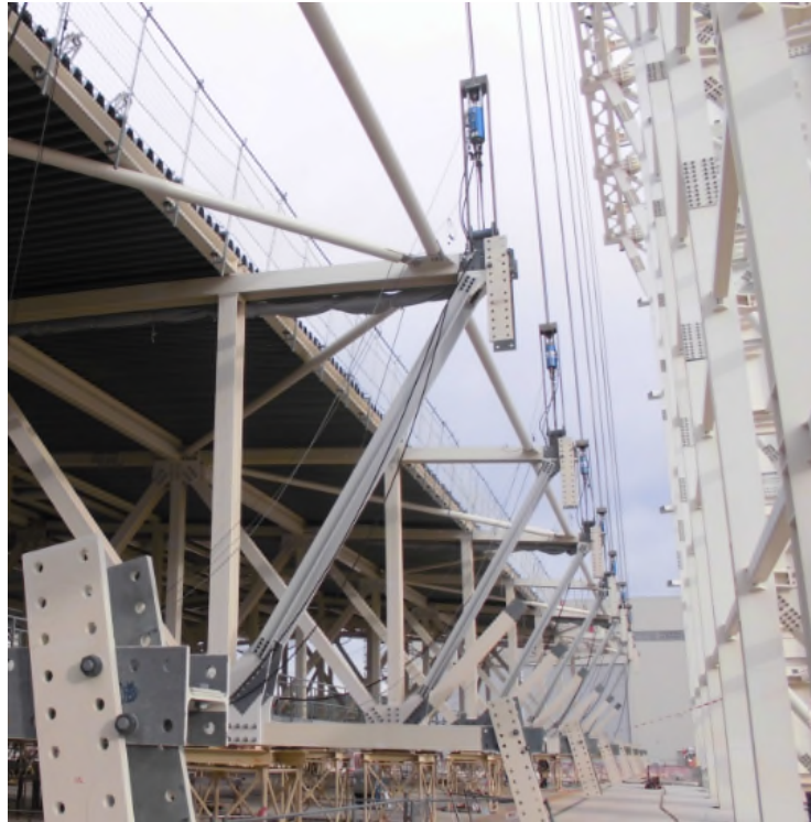
Figura 4. Posición gatos hidráulicos.
