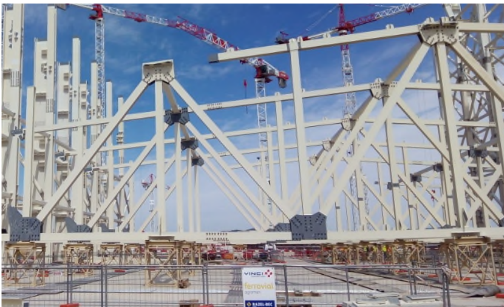
Figura 2. Ensamblaje de la estructura de la cubierta
