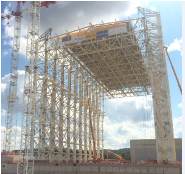
Figura 10. Fin de la operación de izado
