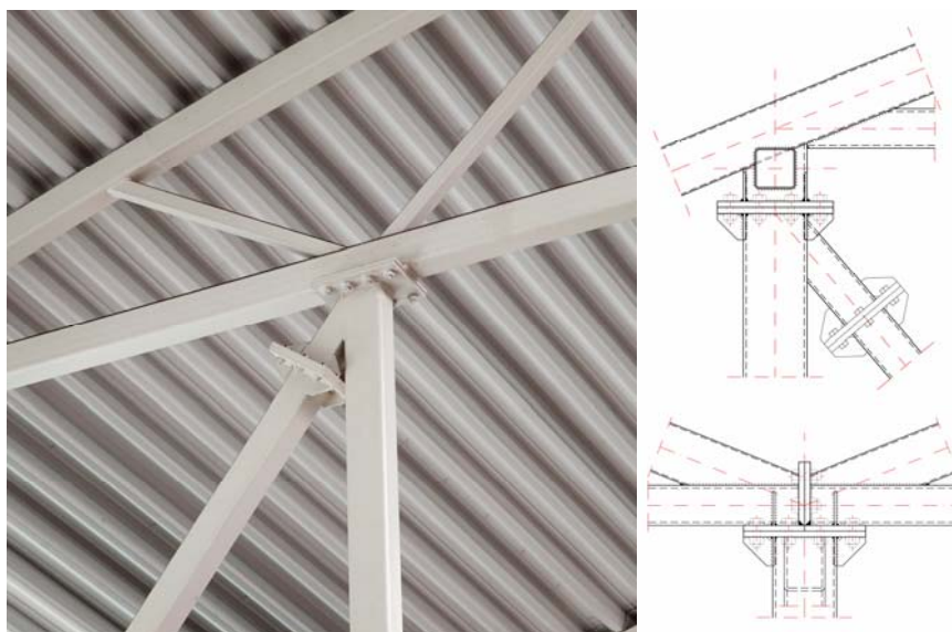
Figura 12. Detalles atornillados para uniones en obra.
