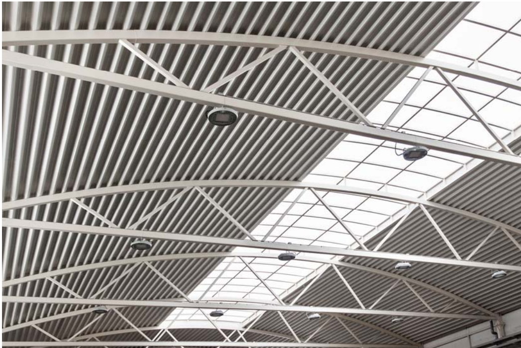
Figura 8. Aspecto definitivo interior de la cubierta.
