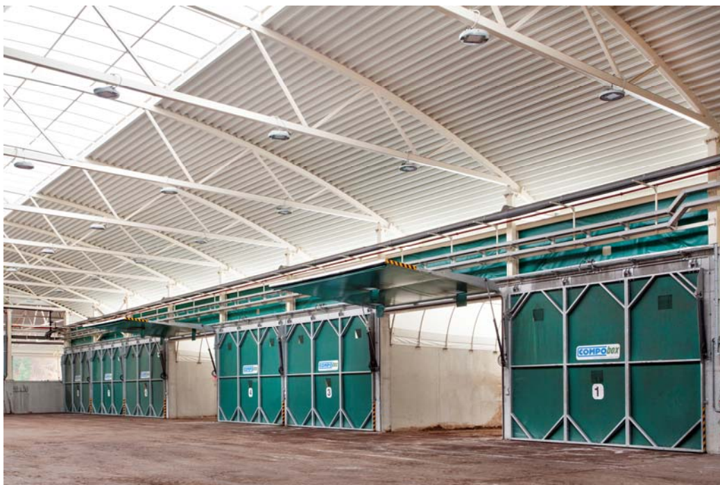
Figura 14. Vista interior de edificio de mezcla terminado.
